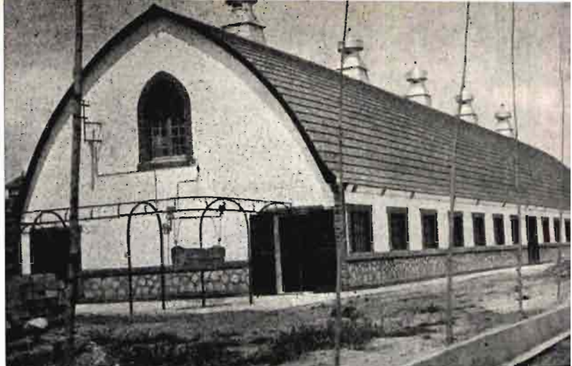
Exterior del establo de "Ventosilla". En primer término vagoneta de suspensión para recogida de estiércoles, que en otras vagonetas son llevados al lejano estercolero. (Foto "Ventosilla".)
