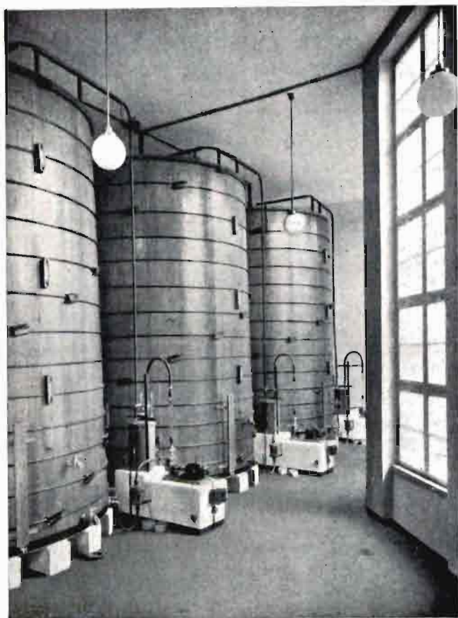
Fig. 6.ª—Batería de generadores verticales sistema Frings. La distribución de líquidos se hace por una turbina única, lo que evita el empleo de depósitos elevados; la regulación de la ventilación puede hacerse muy cómodamente en éste, como en otros sistemas perfeccionados para la gran industria vinagrera.
