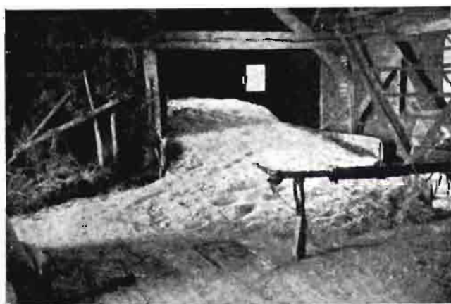
Cuando los locales donde se guarda el grano son húmedos o mal ventilados, con grietas en las paredes y sin cielo raso, resulta difícil descastar a los insectos que los invaden. (U. S. D. A.)
