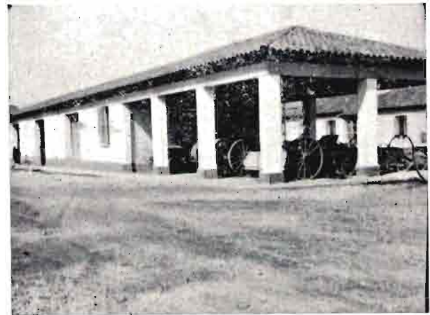
Las máquinas deben protegerse de la intemperie en porches espaciosos, como éste de "La Melusa", explotación modelo de la Mancomunidad Hidrográfica del Ebro. Abandonar las máquinas al aire libre, demuestra tan mala administración como desconocimiento de ellas.
