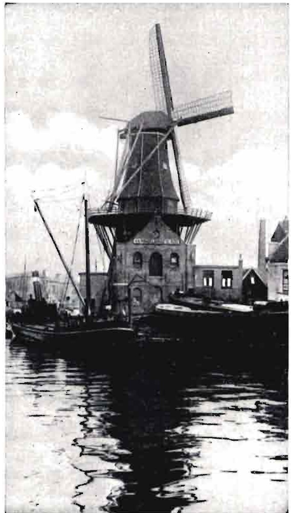
Uno de los muchos molinos que todavía se ven en Holanda, en el interior de las poblaciones; por ello tienen tanta altura.
