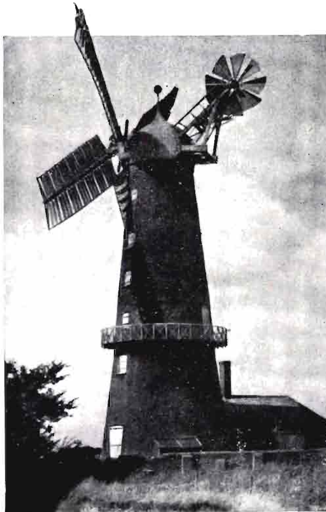
Típico molino inglés, con su timón (rueda eoliana) para orientar automáticamente el molino según la dirección del viento. Molino Wellingore en el Condado de Lincoln.
