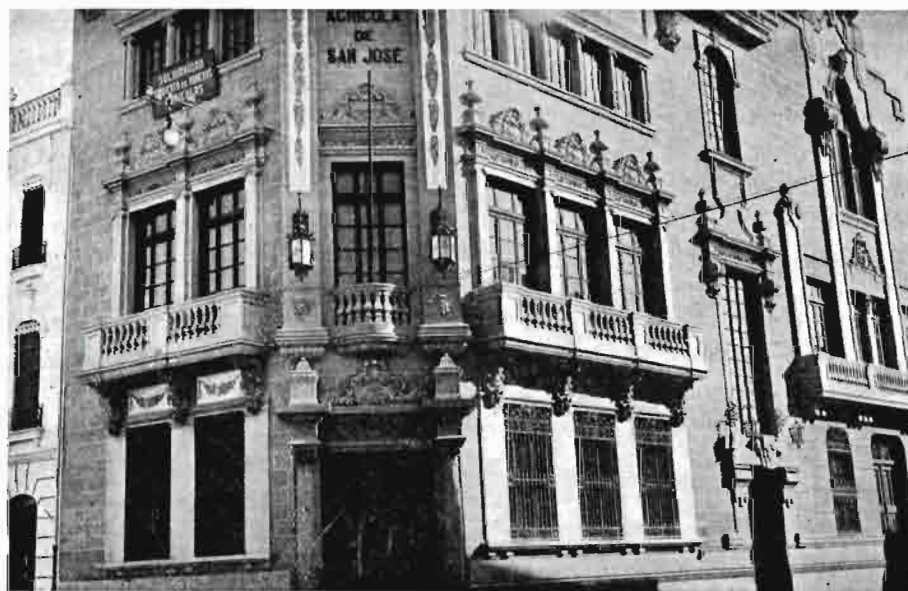
Edificio social del Sindicato Agrícola de San José, de Almazora (Castellón). (Fotos G. a Gisbert.)
