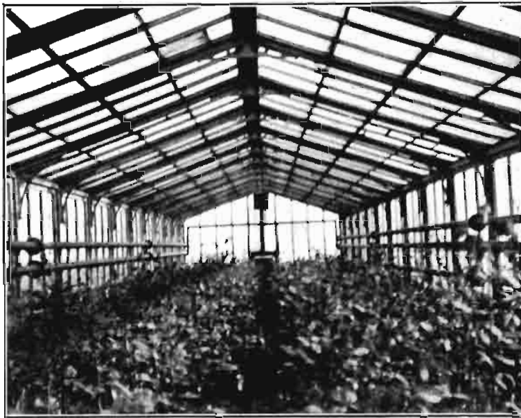
Interior de la estufa reproducido en el grabado número 1. Nótese la disposición de los cuatro tubos de calefacción. (Foto Bornás.)
