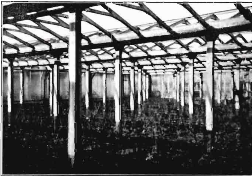
Estufa de armadura fija en hormigón y cristaleras reparables.
