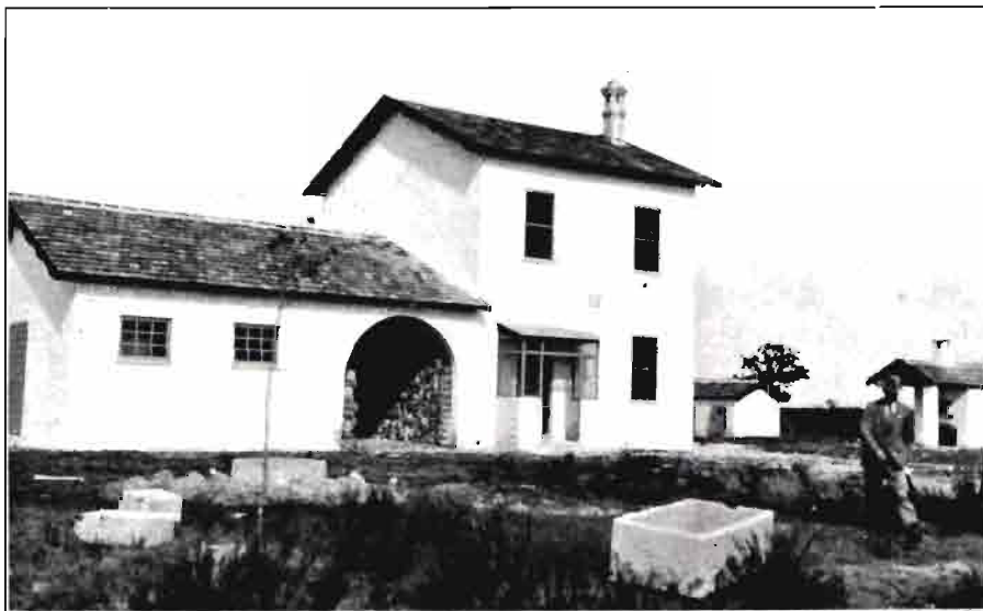
Para los colonos de esta bonita se han construido once tipos de casas diferentes; he aquí uno de ellos. Nótese, a la derecha y en primer término, el horno; en segundo término, el gallinero-cochiquera, y en la nave-almacén los sacos de cal dispuestos para el encalado de los terrenos afectos a esta casa.
