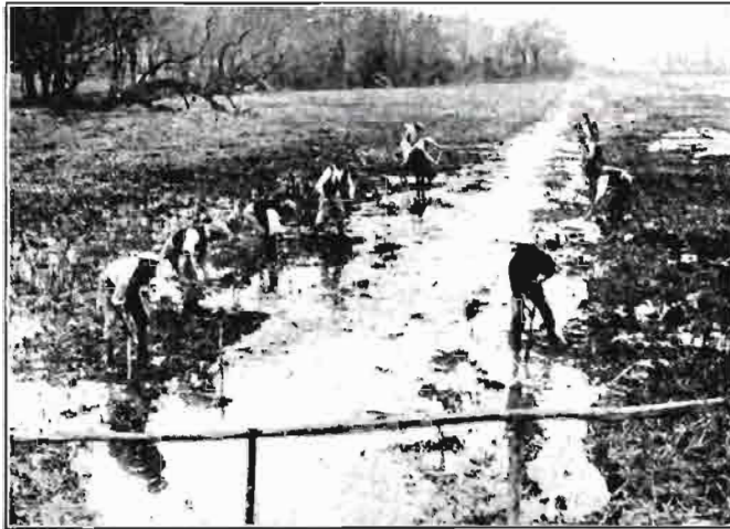
Iniciación de la apertura de un canal de desagüe.
