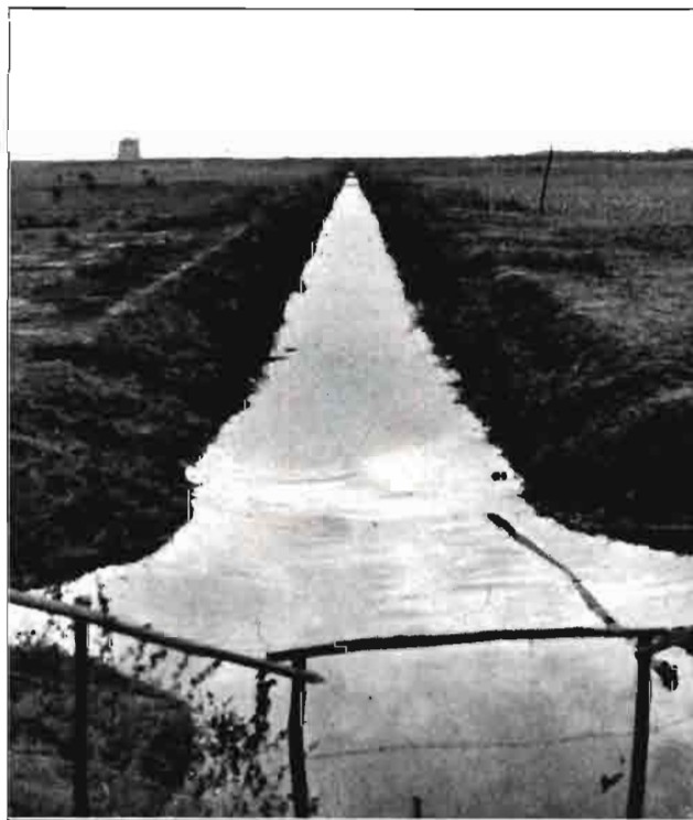
Uno de los pequeños canales que conducen el agua de los terrenos pantanosos a los canales principales.
