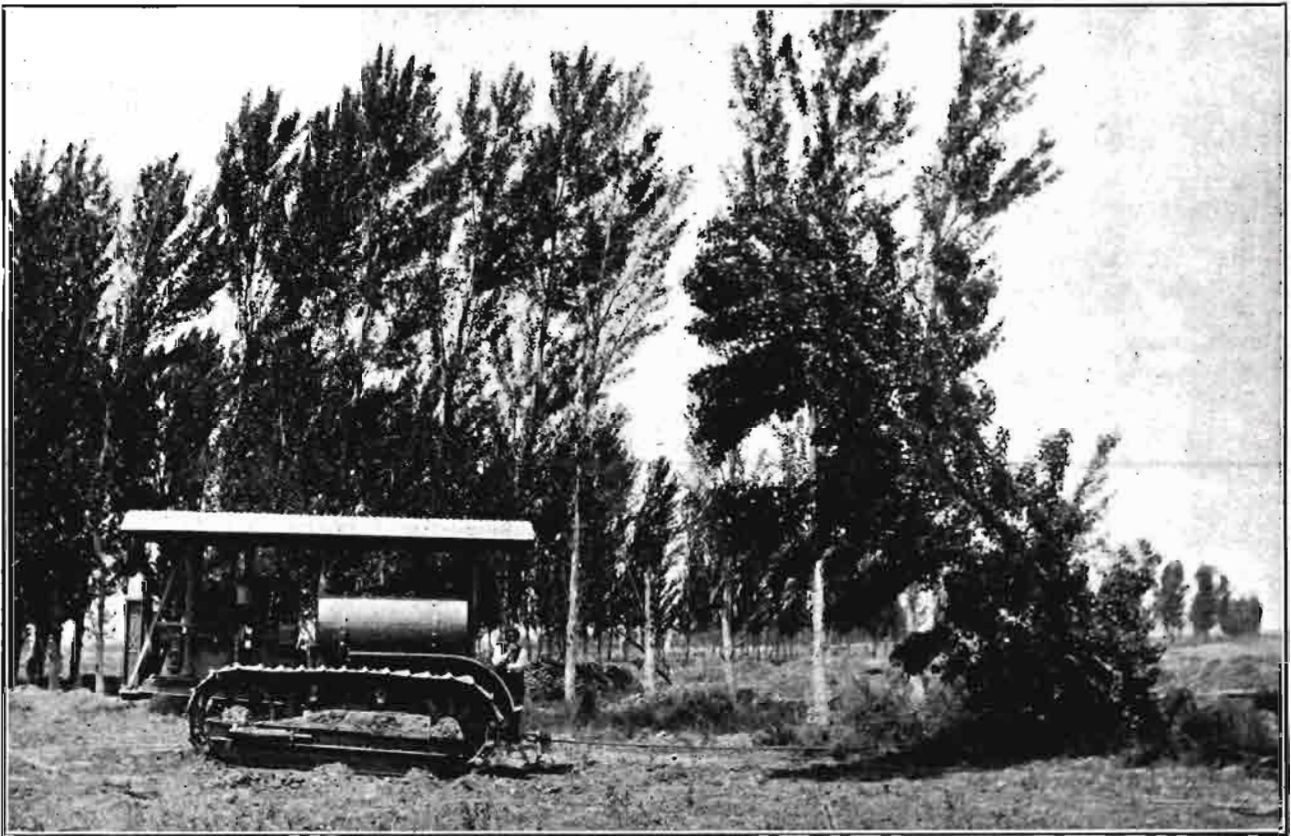
Arranque mecánico de árboles con sus raíces. Este procedimiento puede emplearse igualmente para arranque de tocones.
