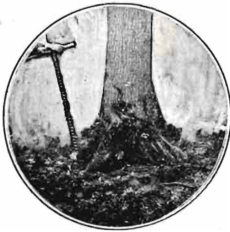
Manera de hacer un taladro para introducir en los tocones las cargas de explosivos.
