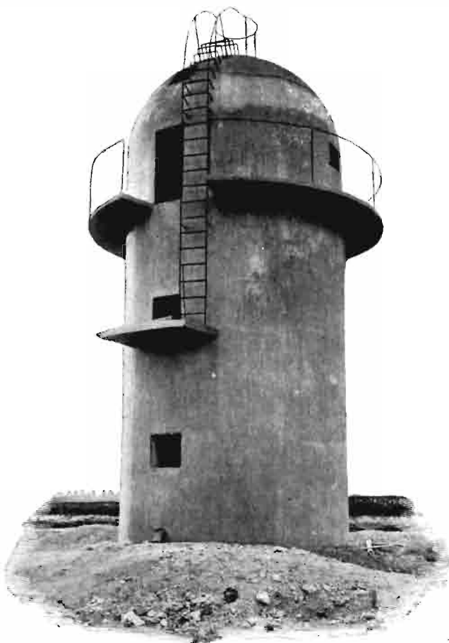
Silo tipo cremasco.
