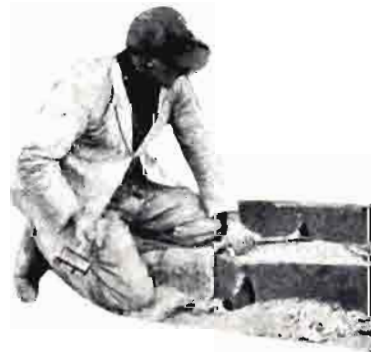
He aquí un operario que procede a perforar el zócalo de un muro para colocar en esas oquedades un sifón Knapen. En la perforación inferior se ve ya embutido este tubo exudatorio de la humedad.
