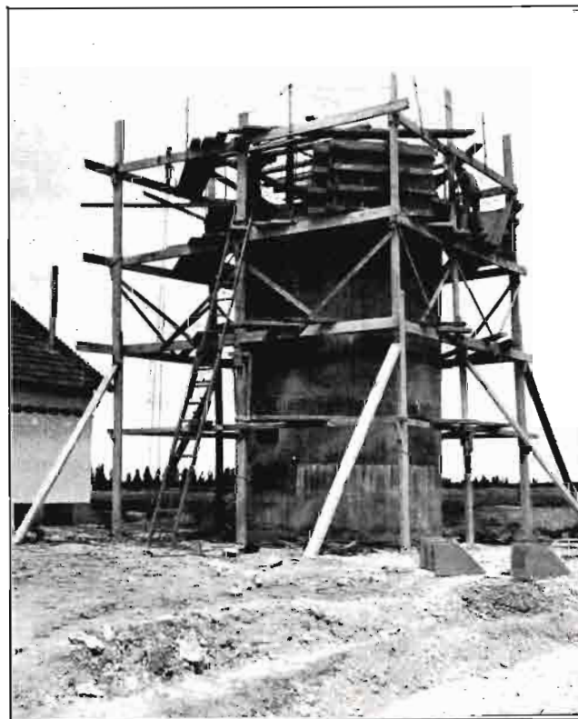
Los silos de hormigón armado se construyen por tramos, previa colocación de los moldes. En la fotografía pueden verse unos y otros.
