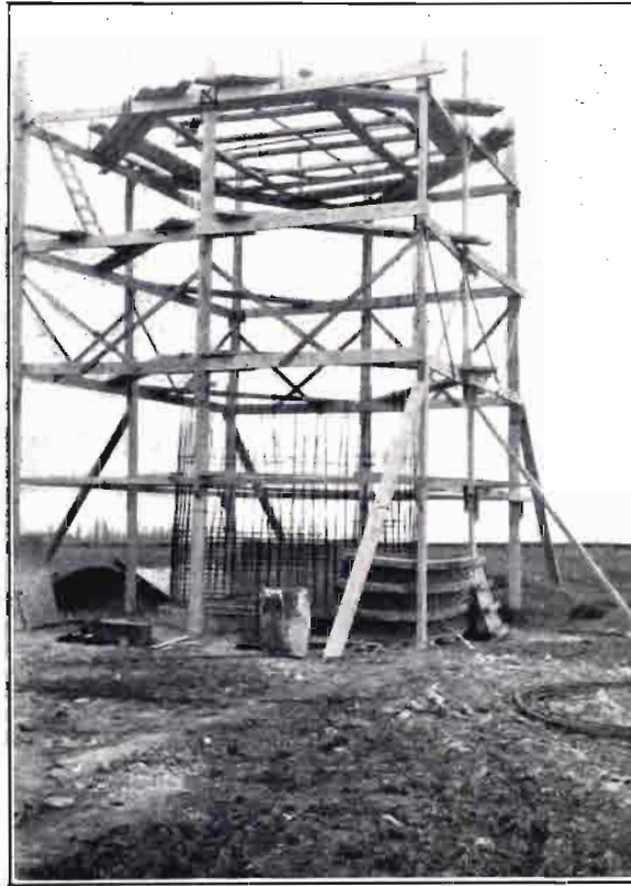
Disposición de la armadura en los silos de hormigón armado.
