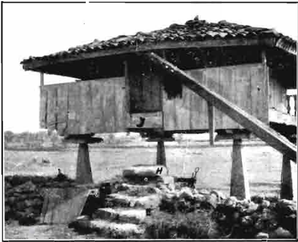
Hórreo de las cercanías de Gijón.—Y, Talamera o escalón de subida; H, Escalera de piedra.
