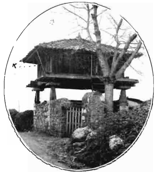
Asturias.—Hórreo del país. K, palos para re- forzar el sostén del tejado.
