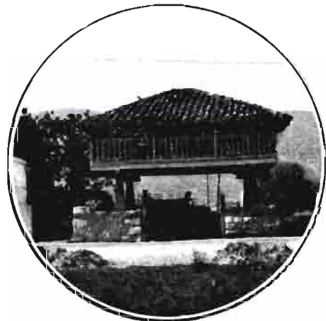
Este hórreo, construido en la carretera de Oviedo, tiene un corredor que en el otoño sirve de sostén para amarrar a él las ristras de maíz que se ponen a secar. Los pegollos descansan sobre un basamento de muro y cierran un espacio bajo el hórreo que se utiliza para guardar carros.
