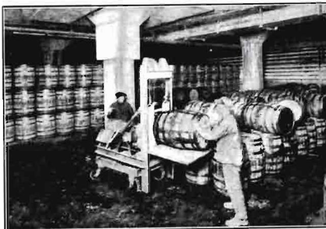
Cámara de congelación, con los tubos de refrigeración en los muros laterales. Véase la manera de colocar los barriles en dicha cámara.
