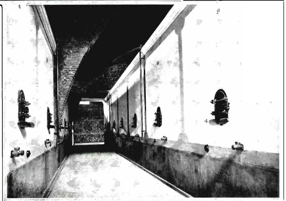
Nave de tinos de fermentación, provistos de compuertas para la salida de la casca, grifos, catavinos y escorrederos para la limpieza de los mismos.
