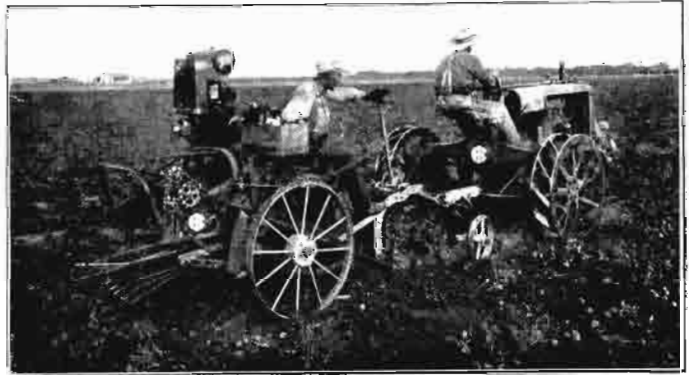
... Un motor auxiliar eliminó parcialmente estos defectos...
