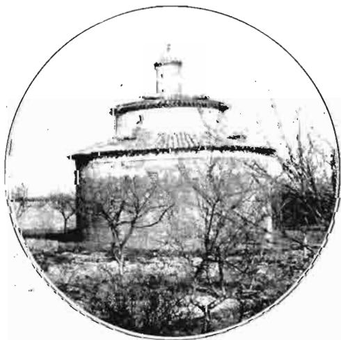
Palomar de dos muros concéntricos, disposición que aumenta considerablemente su capacidad. (Fuentes de Valdepero.)
