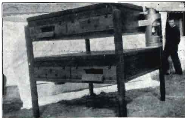
Incubadora para 1.300 huevos, propia de explotación avícola de mediana importancia.
