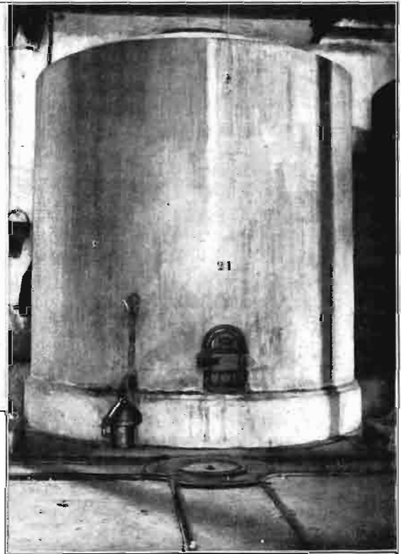
Modelo de envase de cemento armado, empleado en algunas bodegas manchegas.
