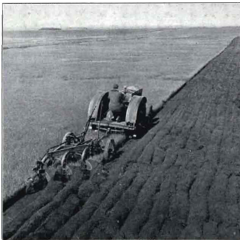
Fig. 1. a —La cohesión de esta tierra da realidad a la teoría del arado, que apoya regularmente los prismas de tierra retorcidos en las vertederas hasta cubrir por completo el rastrojo. La limpieza del surco descubre netamente el fondo o solera y las murallas, por cuya proximidad marchan la rueda interior del tren delantero y la posterior, inclinada para contrarrestar el empuje lateral. La barra del tractor, sensiblemente centrada en su clavijero, ofrece una prueba más de que el tractorista no es un inexperto.
