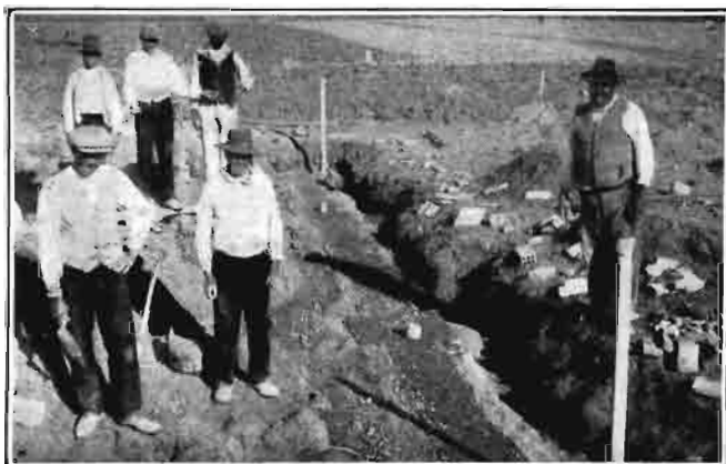
Para el obrero agrícola, la mayor de sus ilusiones estriba en poseer una casa; sus primeros ahorros los destinan a construirse ellos mismos un albergue...
