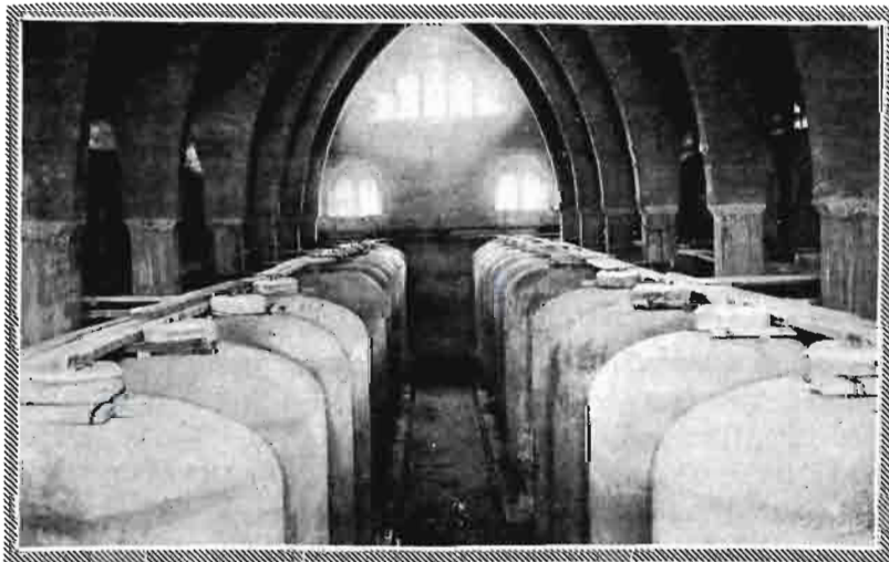
Sala de fermentación, con depósito de hormigón armado, de forma cilíndrica y de cabida de 125 hectolitros.
