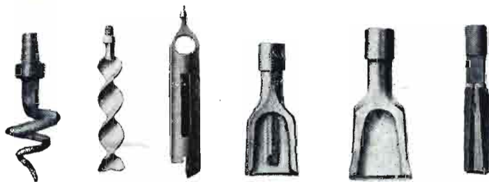
Macho, barrena, cuchara y trépanos empleados para la perforación de pozos.
