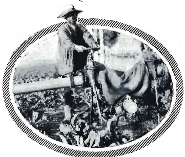
Un obrero abriendo la llave de paso que pone en comunicación la red principal con una de las alas de riego.
