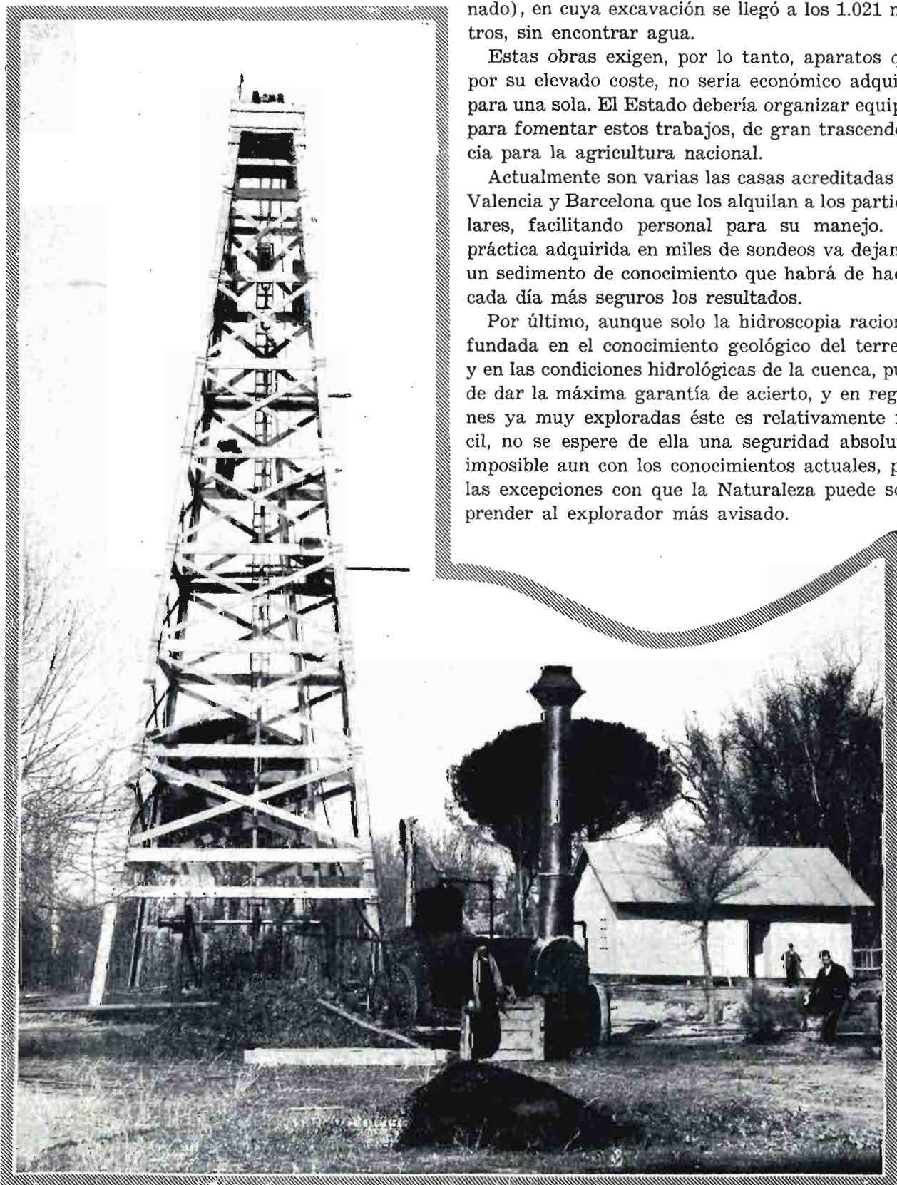
Uno de los equipos de perforación utilizados en el alambramiento de aguas artesianas en El Pardo por el Ingeniero agrónomo señor Janini.
