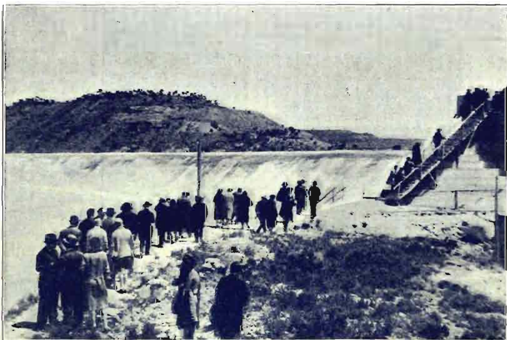
Otra bonita vista de la presa de Ardisa nos lo proporciona el aliviadero de descarga de la misma, produciendo la caída de la gran cantidad de agua un fantástico e interesante aspecto....
