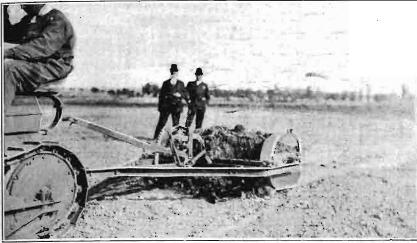
Equipo nivelando una parcela.
