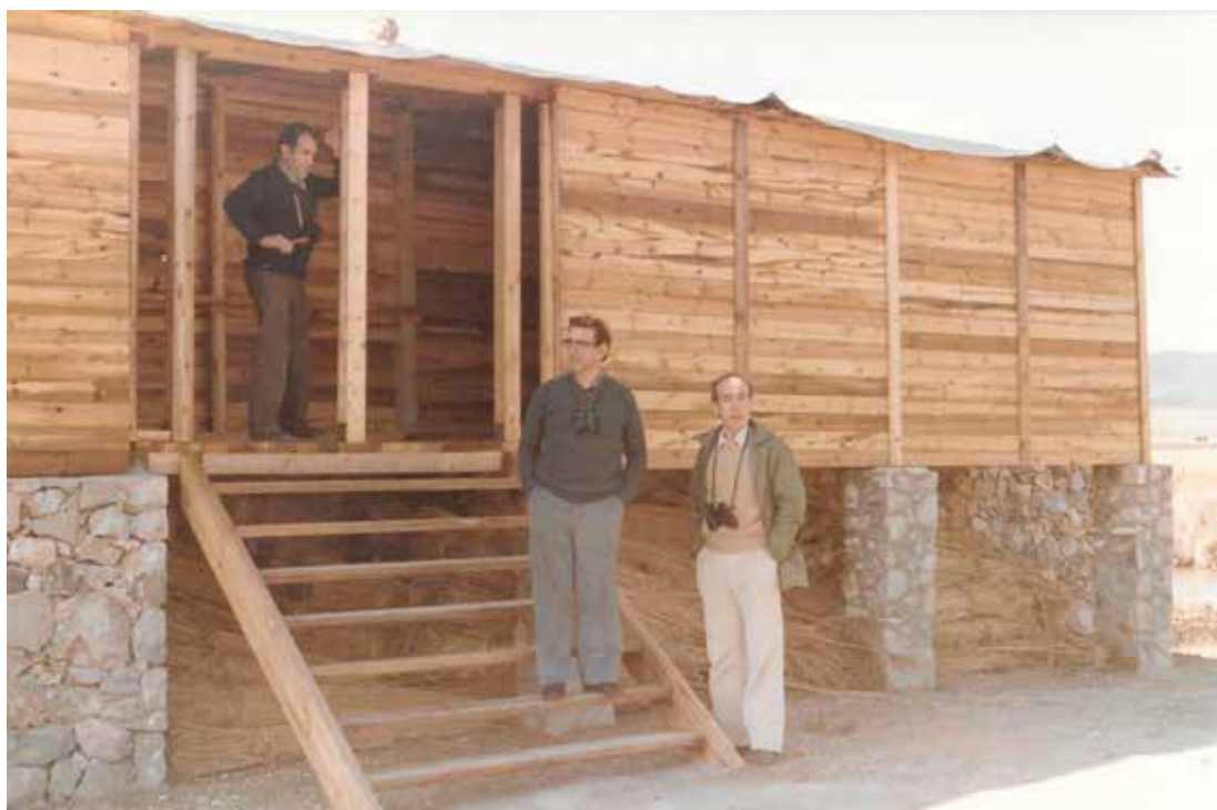
A punto de terminar con la construcción del Observatorio de la isla de Algeciras.
