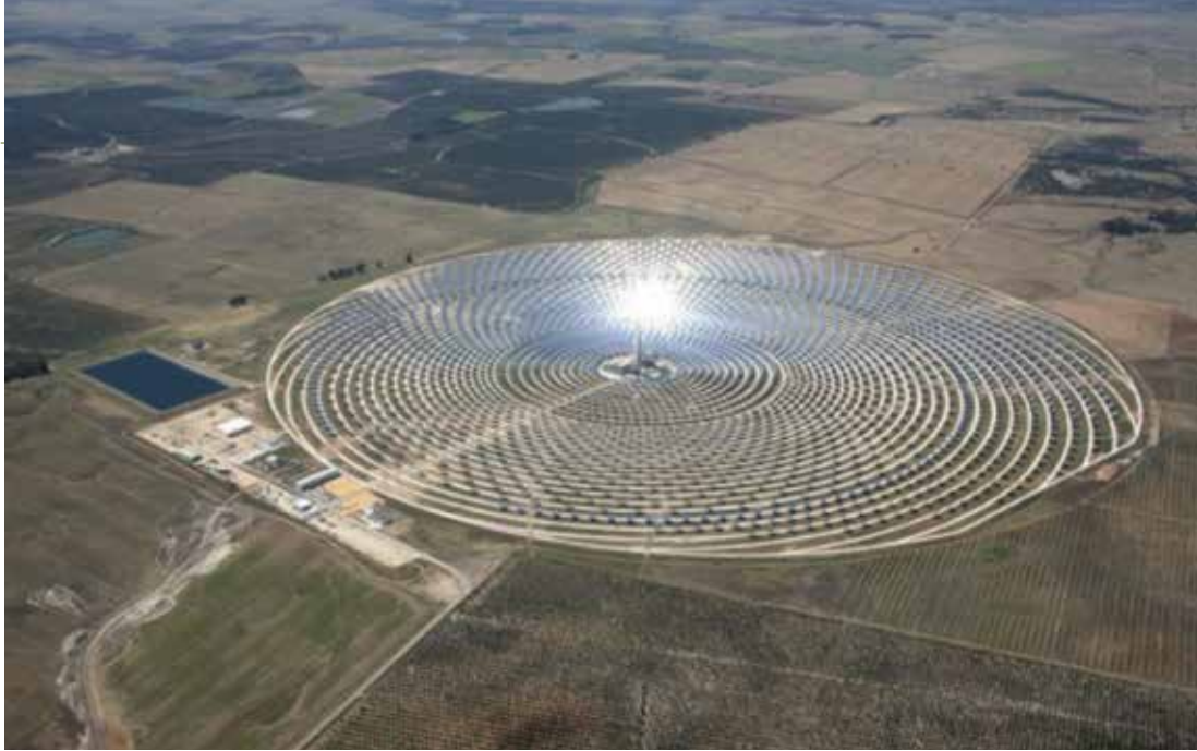
Figura 6. Central termo-solar. Unos espejos controlados mediante ordenadores, concentran la luz solar en un punto de una torre en el centro del cuasi-círculo. En la torre un fluido inorgánico se calienta hasta temperaturas de 700°C. El calor recogido en la torre se almacena en sales fundidas de litio, sodio y potasio para ser recuperado durante la noche.
