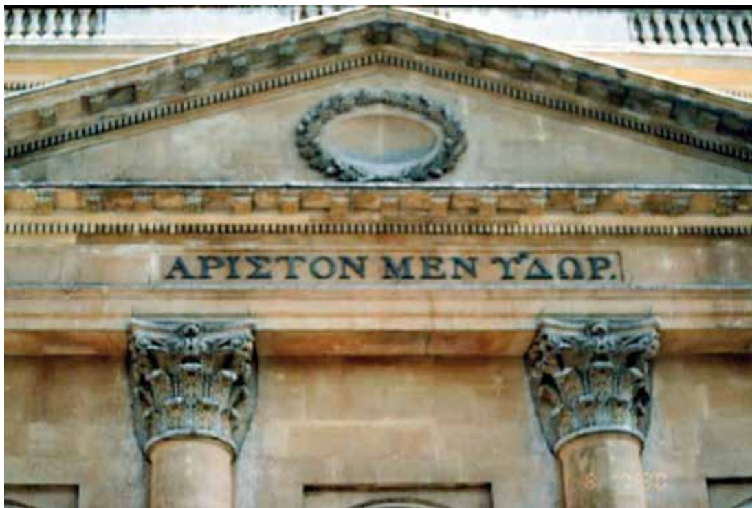
El agua es el mejor. Estación de bombeo de Bath. Foto: M.M.Curran.
