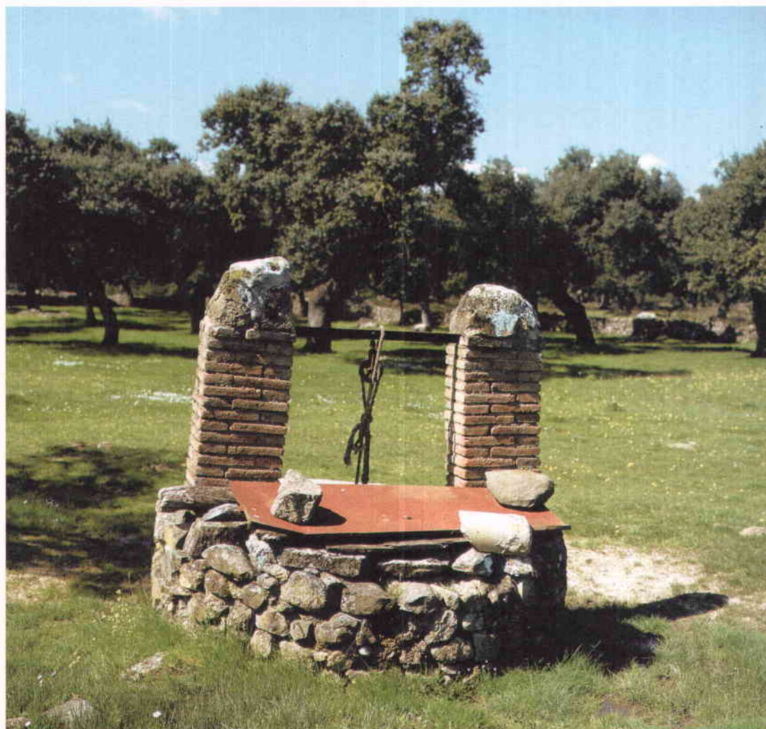
En muchas zonas la disponibilidad de agua subterránea solo es posible ya mediante extracción en pozos cada vez más profundos, lo que en bastantes casos hace inaccesible el agua por motivos económicos. Foto: Carlos Valdecantos. CENEAM. MAGRAMA
