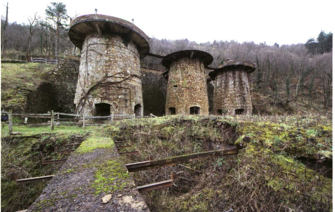
Restauración de la zona de los hornos de calcinación del Conjunto Monumental de las Minas de Aizpea.
