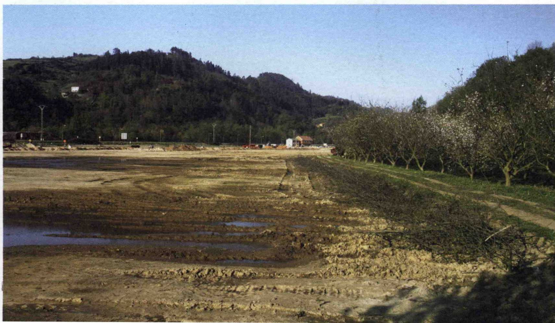
Detalle del arranque del suelo en la vega de Tudela (Asturias) y la destrucción de las plantaciones y formas tradicionales.
