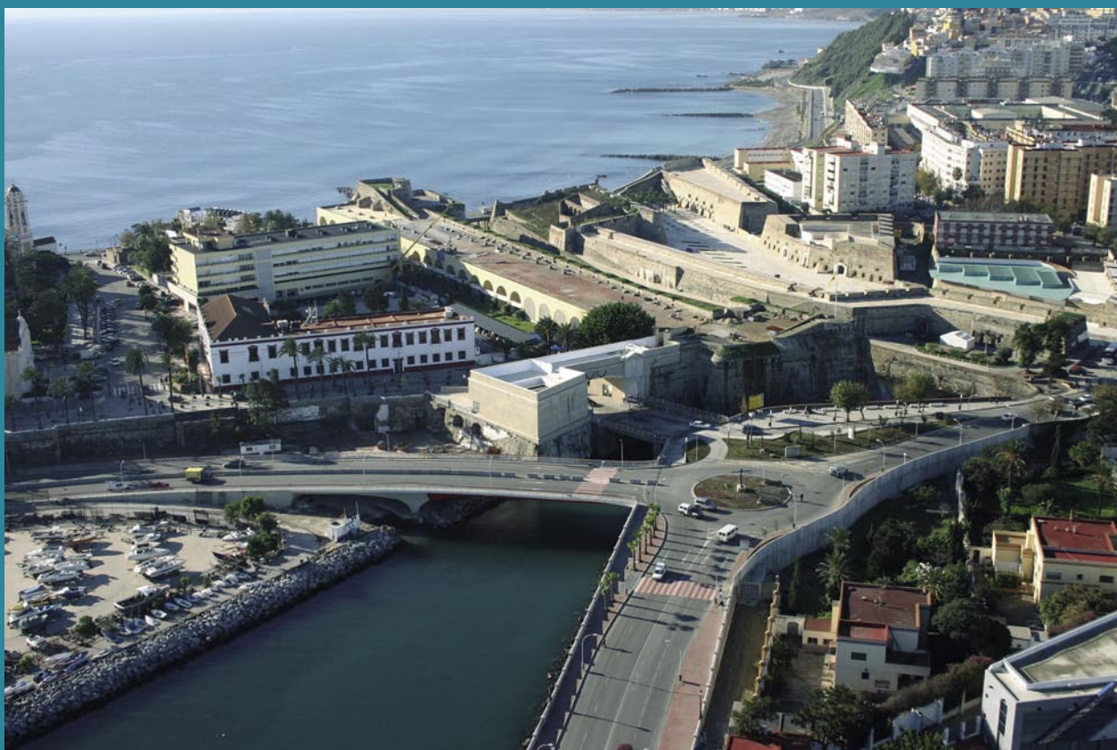
La ciudad autónoma de Ceuta tiene graves problemas de abastecimiento y saneamiento de agua.
