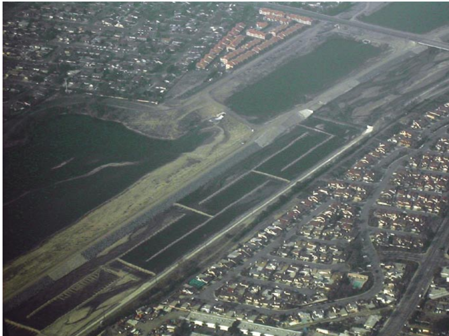
Vista aérea de las lagunas de infiltración junto al cauce y en el interior del cauce del río Santa Ana, en las que se recarga el acuífero con aguas superficiales y aguas regeneradas.
