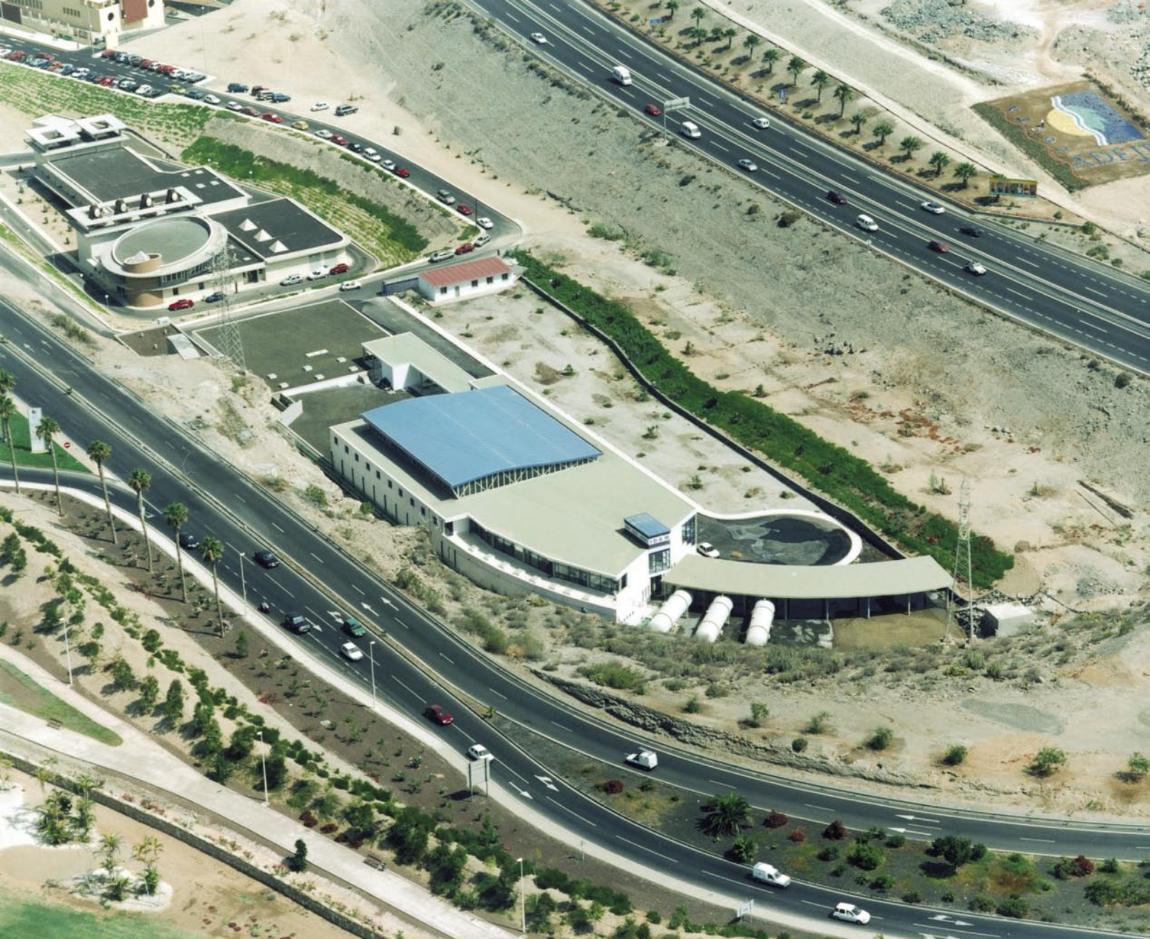
Desaladora de Adeje-Arona
