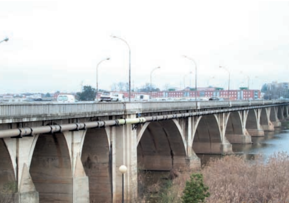
■ Finalización montaje tubería colgada sobre el Puente de Universidad.
