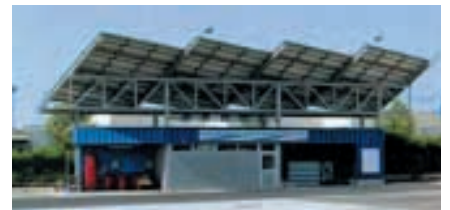
■ Zona de recuperación del agua utilizada por el sistema de ósmosis inversa.
