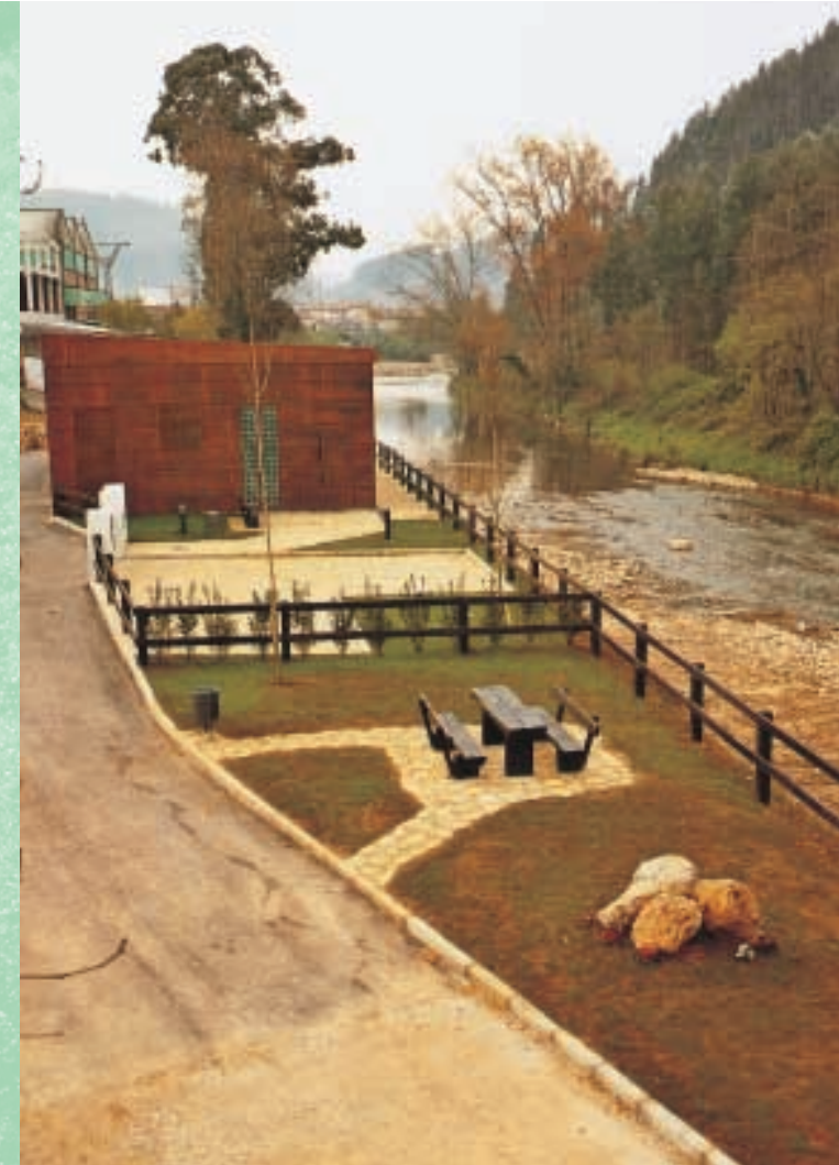
■ Estación de bombeo de Cartes.
