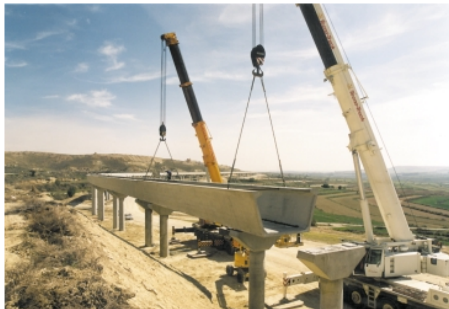
■ Obras de reparación de la acequia de la Violada, que mejorarán una de las principales arterias del sistema de Riegos del Alto Aragón.
