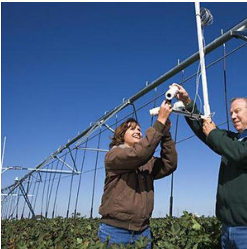
Figura: Montaje de sensores de infrarrojos a intervalos regulares en los tramos del sistema de riego de pivote central para medir T_{leaf} . Utilizando otros sensores infrarrojos estacionarios dispuestos en el campo, se verifican estas mediciones
