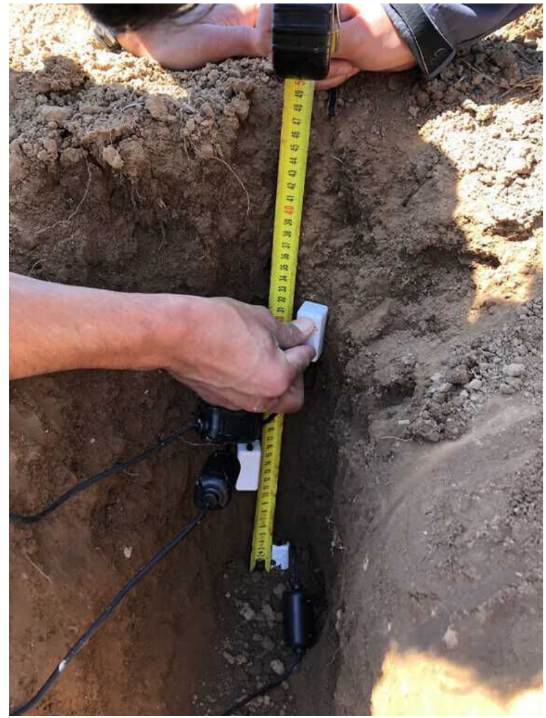
Instalación de los sensores verticalmente
