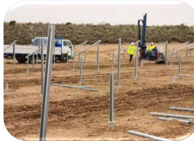
*Estructura Fija con tornillo de fundamento*
