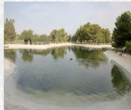
Estanque acumulación Capacidad 3.400 m 3
