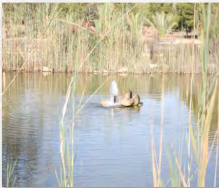
Entrada agua desalada
