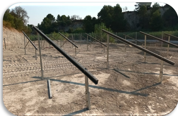
Estructura Fija hincada al terreno
