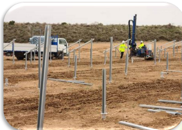
Estructura Fija con tornillo de fundamento
