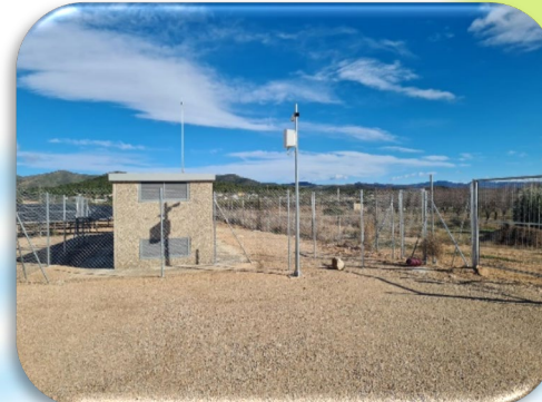
Casetas de CT y vallados
