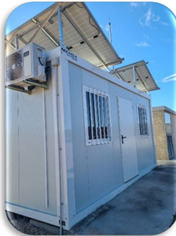
Casetas servicios auxiliares
