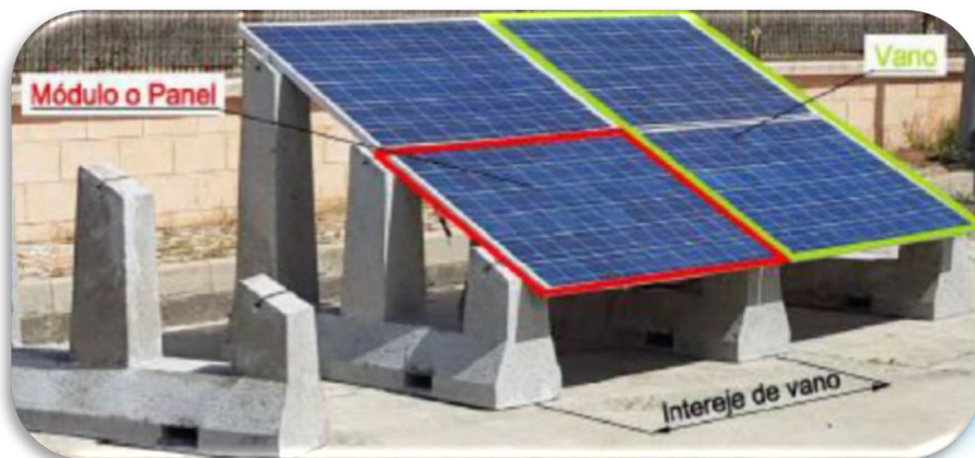
Estructura apoyada en el terreno
