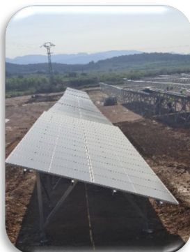
Paneles y estructura
