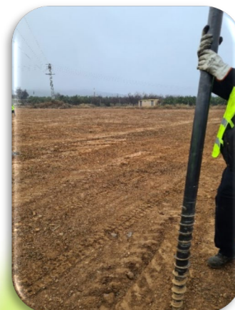
Estructura Fija con tornillo de fundamento
