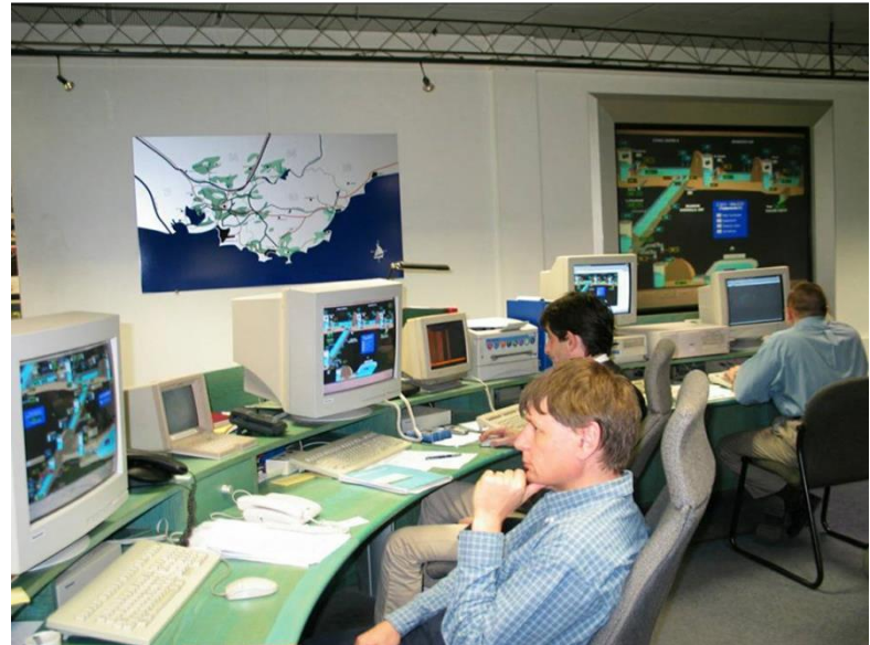
Canal de Provence
