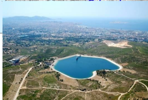
tanque de almacenaje abajo
