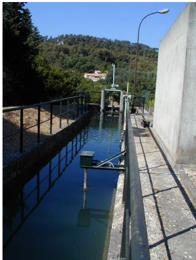
Supervision de la calidad del agua (ISO 14001)
