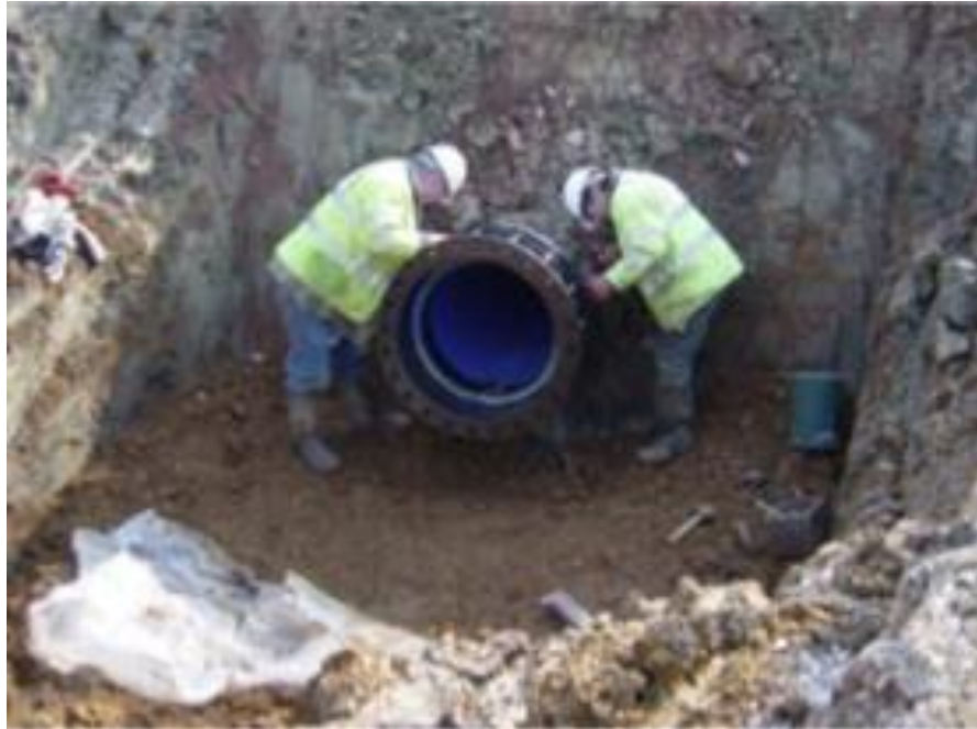
JUNTA AJUSTABLE CON BRIDA PARA PVC ORIENTADO DN 630
