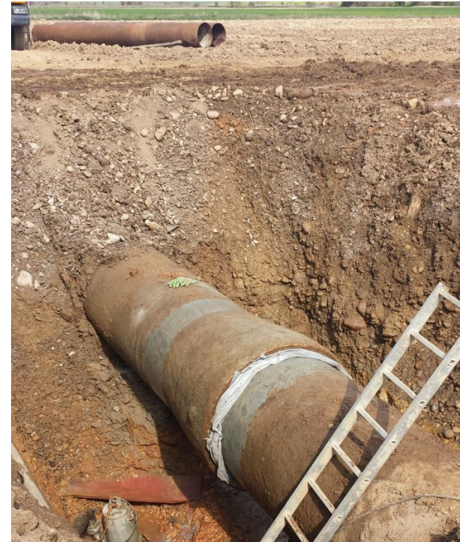
TUBERÍA DE HORMIGÓN ARMADO SIN CAMISA DN 1000
