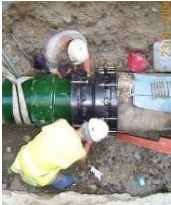
JUNTA AISLANTE PARA FIBROCEMENTO DN 600/450
