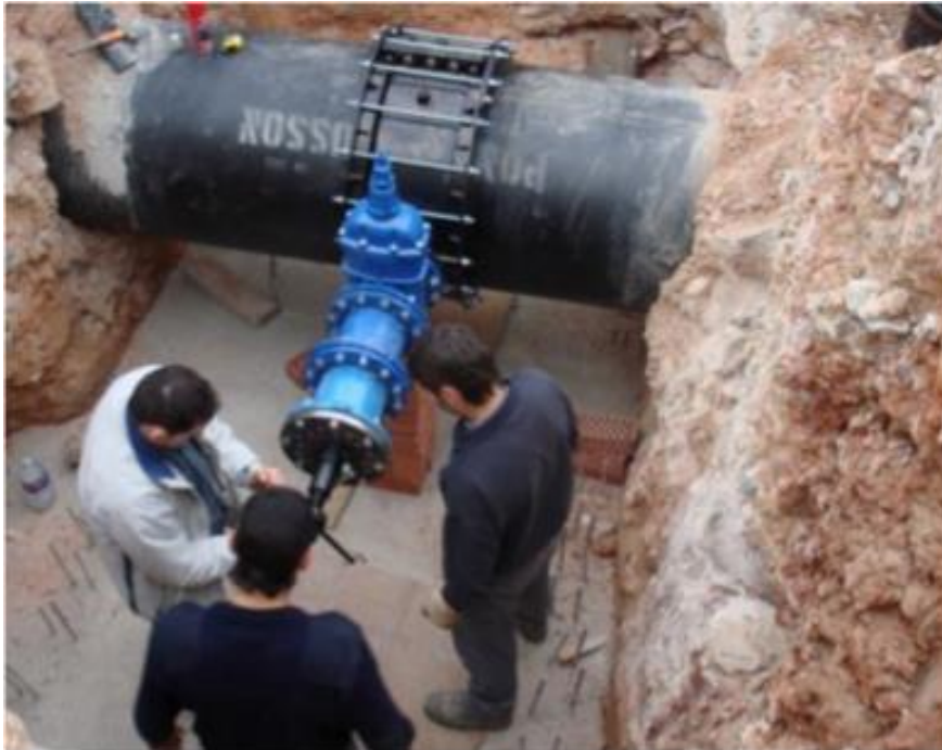
TUBERÍA DE FUNDICIÓN DÚCTIL DN 1000
