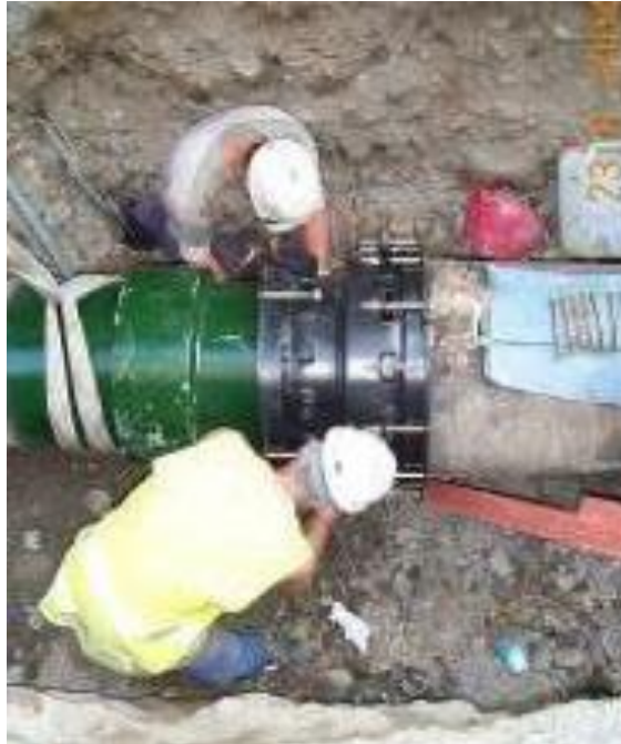
JUNTA AISLANTE PARA FIBROCEMENTO DN 600/450
