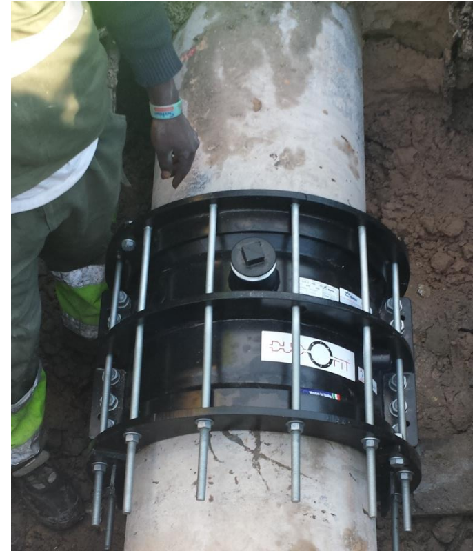
TUBERÍA DE FIBROCEMENTO DN 400
