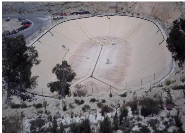
Instalación de cubierta flotante en balsa de lixiviados del vertedero de residuos industriales de Campello 3.000 m 2
