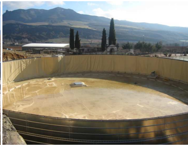
Instalación de cubierta flotante en depósito de agua potable. 1.000 m 2
