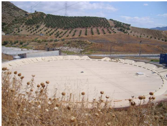
Impermeabilización e instalación de cubierta flotante en depósito de agua potable y riego. 1.000 m 2
