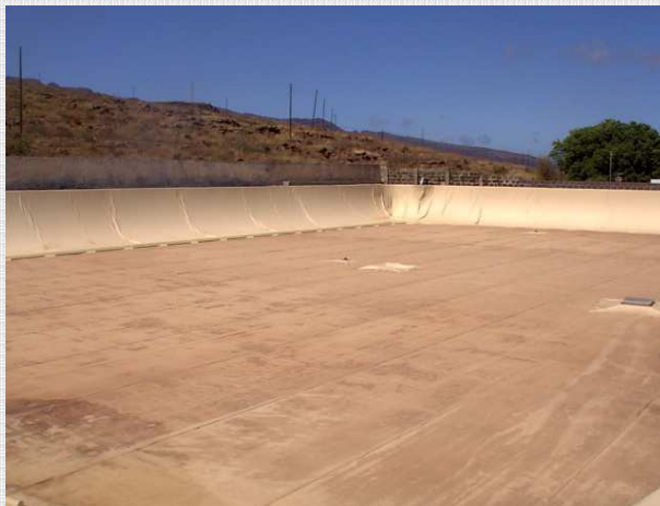
Impermeabilización e instalación de cubierta flotante en depósito de agua potable Los Cardones. 10.000 m 2
