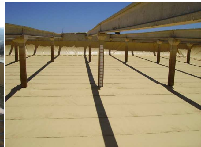
Instalación de cubierta flotante en los depósitos de agua potable Maneje. 8.500 m 2
