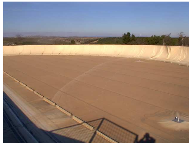
Impermeabilización en depósito de agua residual de los Leones. 1.000 m 2
