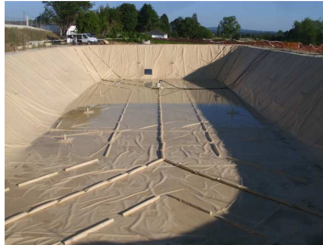
Instalación de cubierta flotante en laguna de purines. 2.000 m 2
