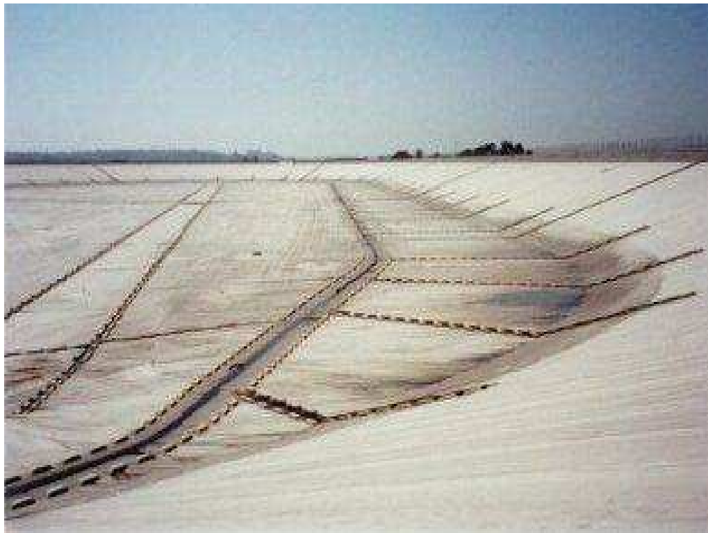
Cubierta flotante en polipropileno armado de 235.000 m 2
