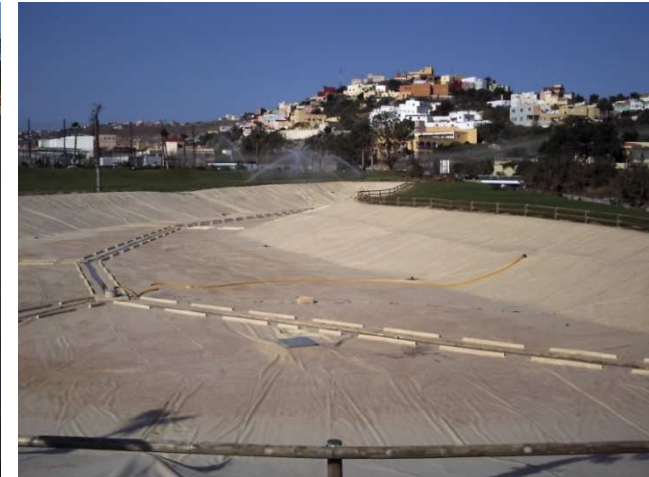
Instalación de cubierta flotante en lago del Campo de golf de Melilla. 5.000 m 2
