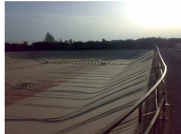
Impermeabilización e instalación de cubierta flotante en depósitos de agua potable La Motilla. 14.000 m 2
