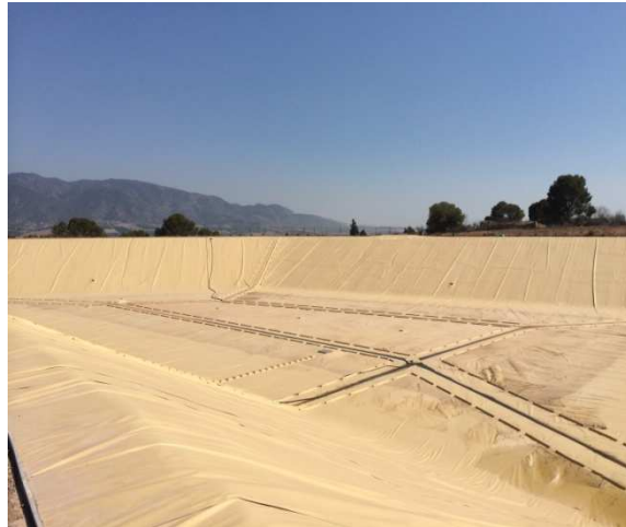
Instalación de cubierta flotante en balsa de riego. 19.000 m 2
