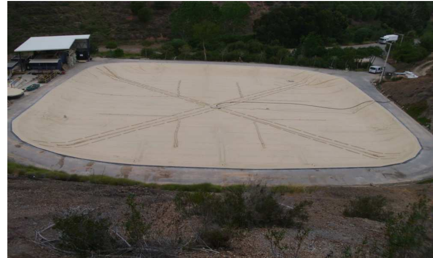
Instalación de cubierta flotante en 1 balsa de almacenamiento de lixiviados. 5.000 m 2
