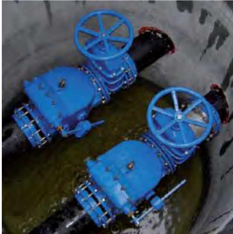
Instalación de retenciones de clapeta oscilante con peso y palanca en posición horizontal
