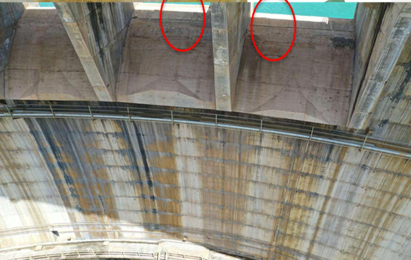
Imagen del paramento aguas abajo tomada con Dron como las juntas de bloque 1-3 y 3-5 (círculos azules) y
