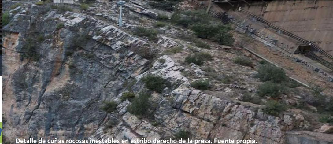
Detalle de cuñas rocosas inestables en estribo derecho de la presa. Fuente propia.
