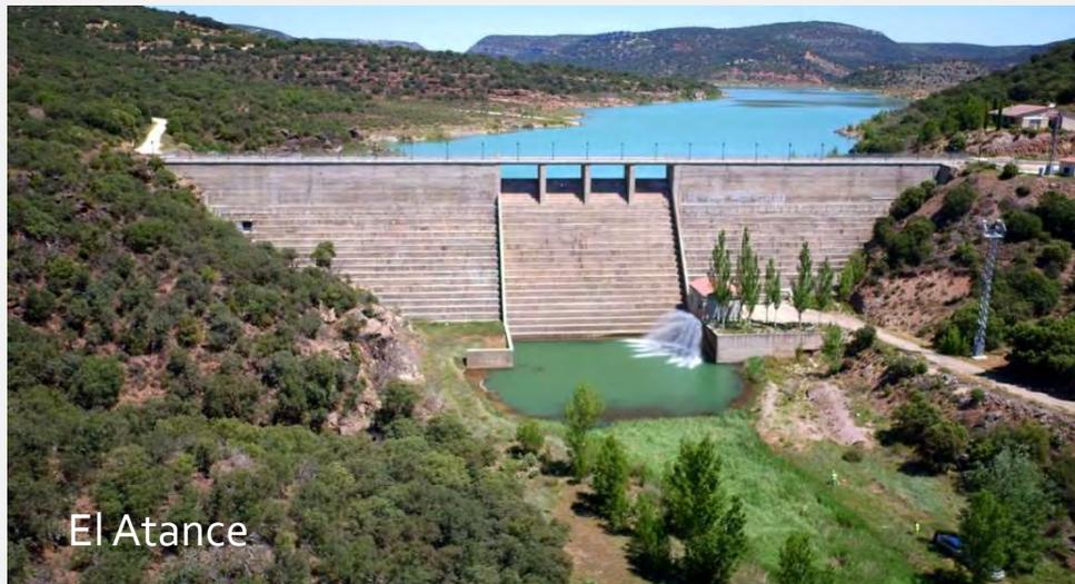
Los datos a obtener mediante la tecnología de drones y sus cámaras aplicadas son los datos topográficos y fotográficos tanto del cuerpo de presa como de sus elementos más singulares: aliviadero, cuenco amortiguador, desagües, etc.
