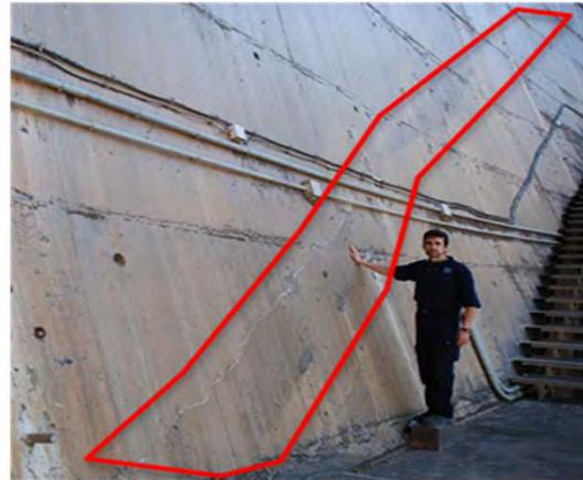
Fisuración en el paramento de la presa aguas abajo, estribo izquierdo (foto superior y abajo a la derecha) y estribo derecho (fotografía abajo a la izquierda) aparecida después de 1991. Estribo izquierdo. Fuente elaboración propia.
