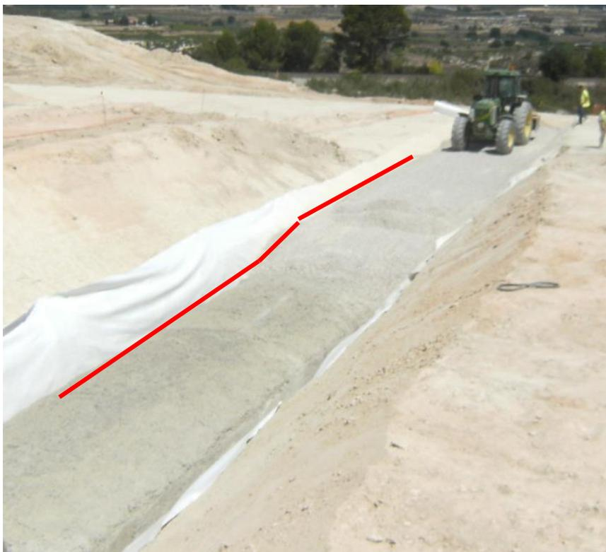
EXTENDIDO DE GRAVAS SOBRE HORMIGÓN DE PROTECCIÓN
