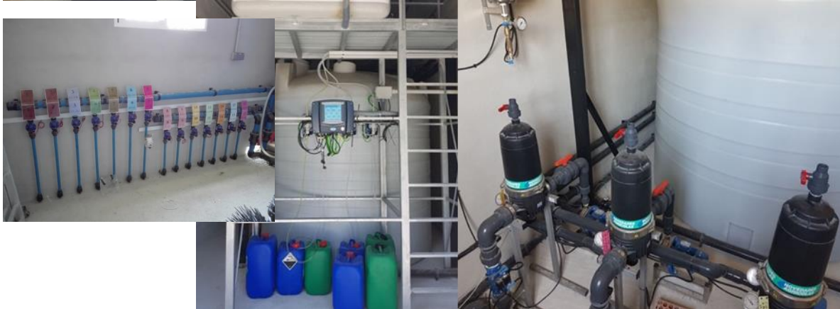
Equipo de fertirrigación: sistema de programación, tanques y bombas de riego
