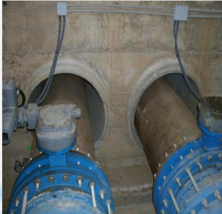
Vaina de hormigón-tubería de acero
