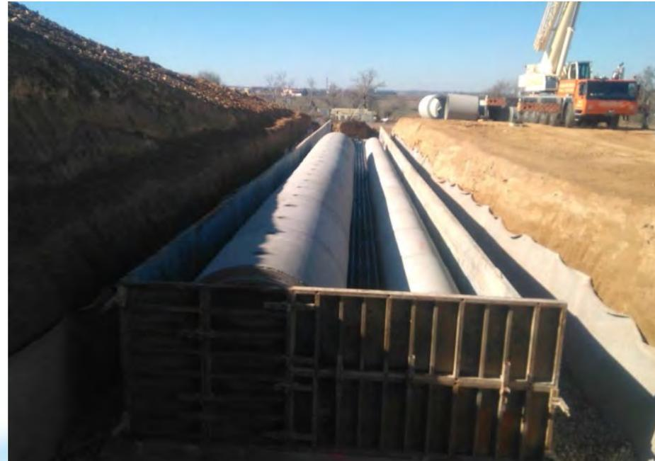
Envainadas en tuberías de hormigón y envueltas en hormigón en masa
