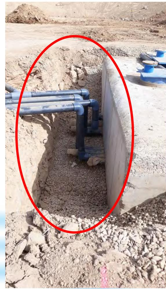
Unión estanca tuberías de drenaje – colectores
