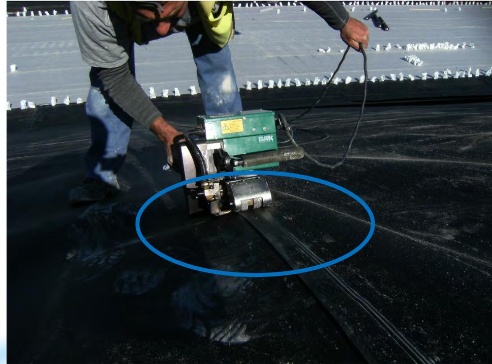
Unión lamina PEAD mediante termofusión doble cuña
