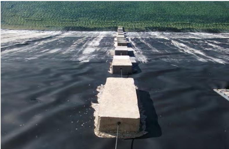
Bloques de hormigón y cable de acero
