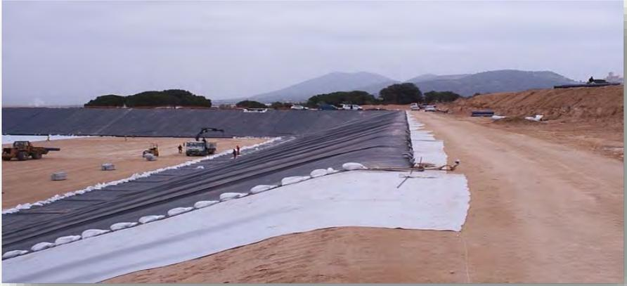
**Geotextil, lámina, anclaje con varilla y lastrado.**
