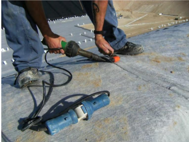
Unión geotextil mediante
