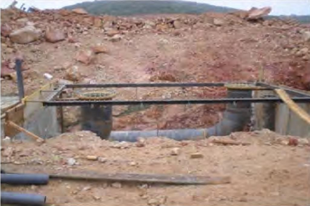
Dado de unión lamina-tuberías (doble unión)
