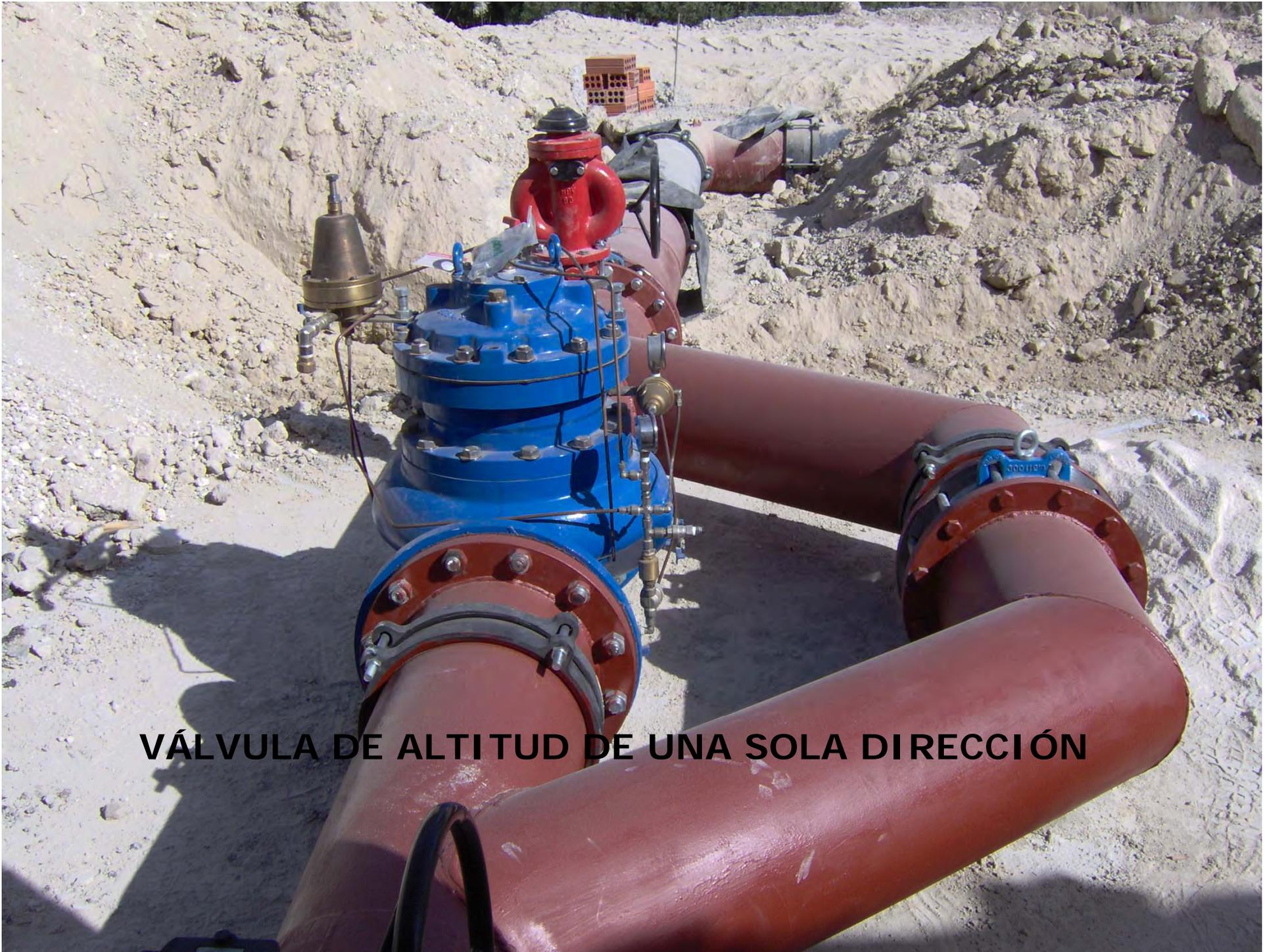
**VÁLVULA DE ALTITUD DE UNA SOLA DIRECCIÓN**
