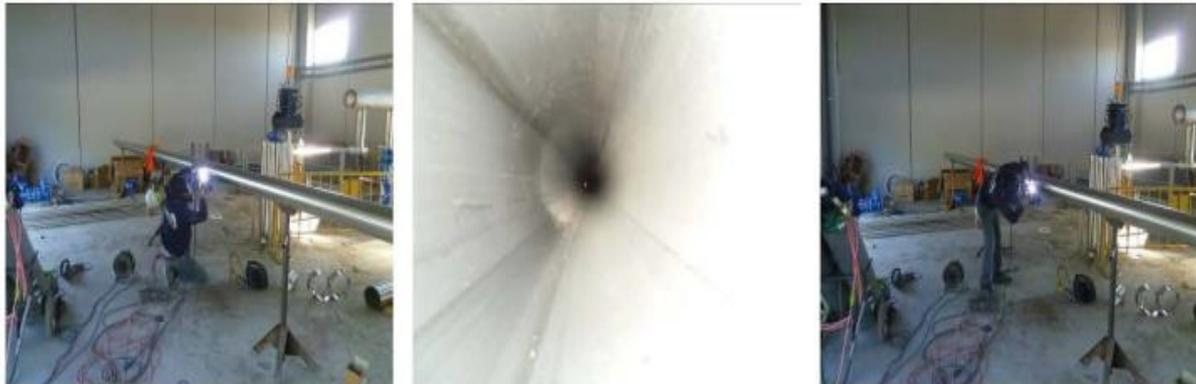
*En foto central vista interior del colector que se estaba soldando (el punto rojo es el material de aporte fundido) sin usarse purga.*
