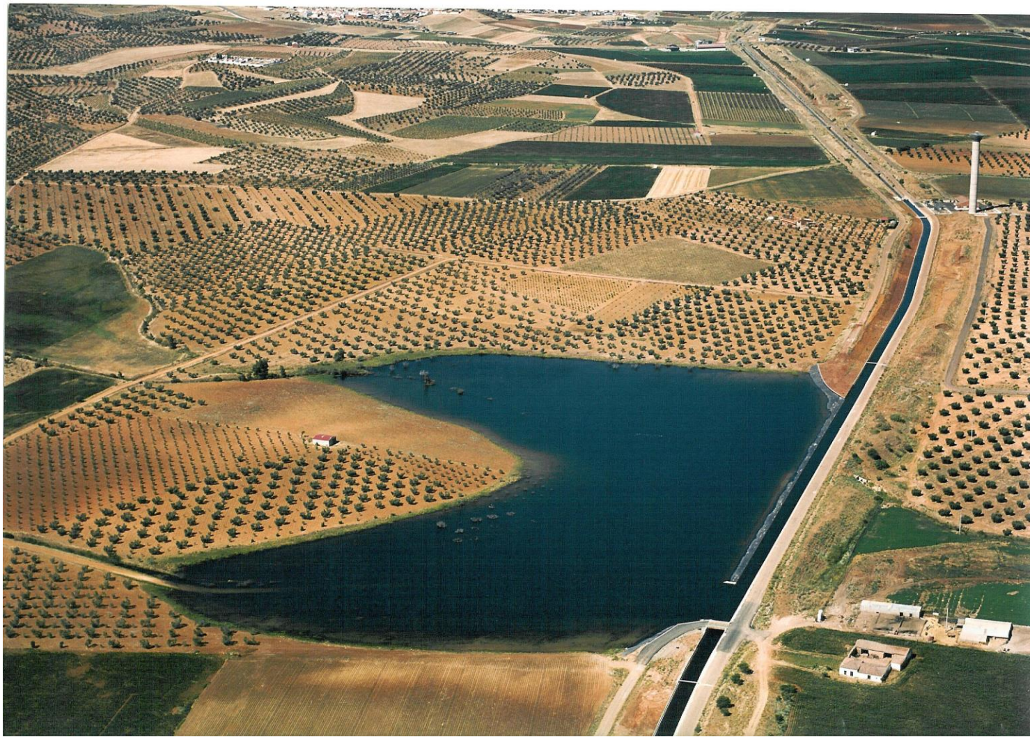
realización de balsas
