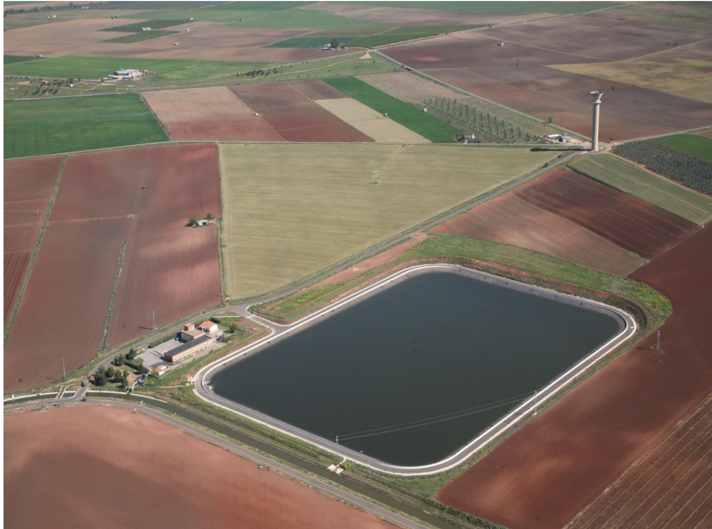
realización de balsas
