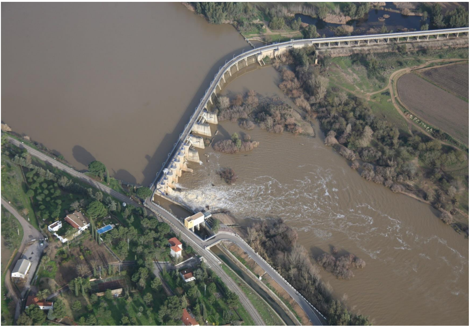
presa de Montijo en explotación, año 2010
