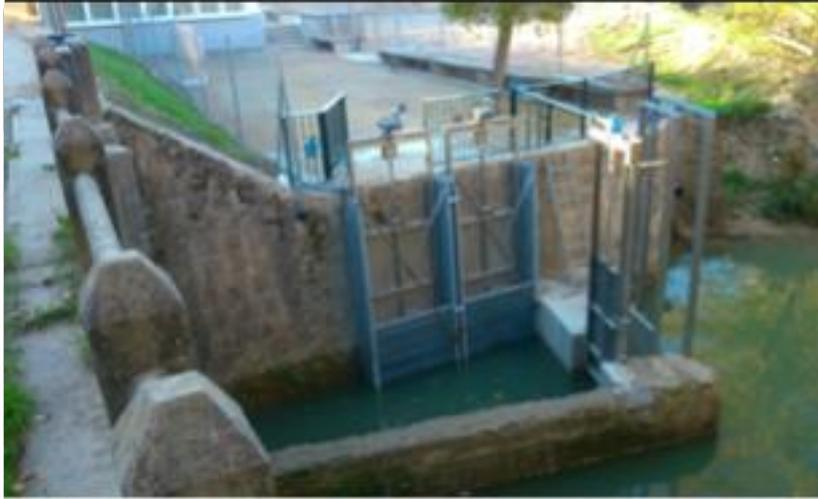
Imagen 1: Vista de las compuertas y las rejas en la cántara de la estación de bombeo
