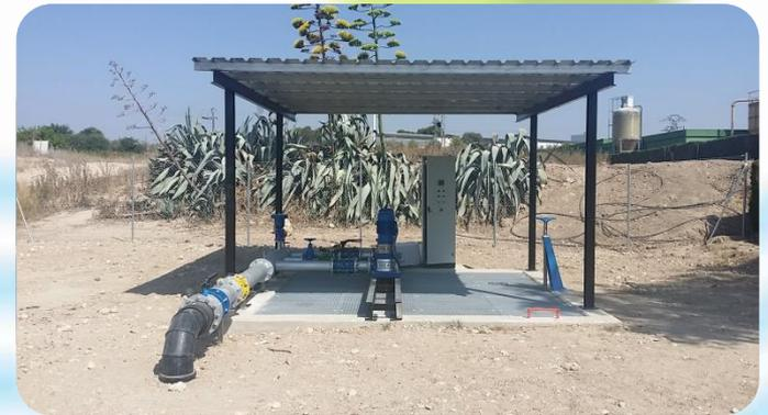
*Depósito enterrado de toma de las aguas e impulsión de la EDAR*
