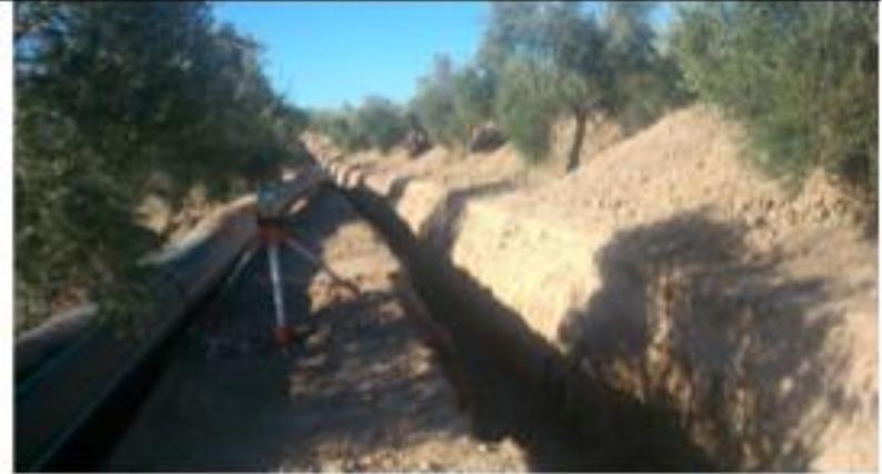
Imagen 2: Montaje de tubería de PEAD 630 mm en la impulsión a la balsa. P.K. 0+338
