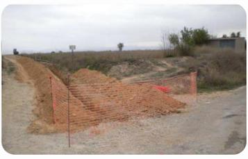
*Balizamiento zanjas y tapones tubería para evitar entrada animales interior.*
