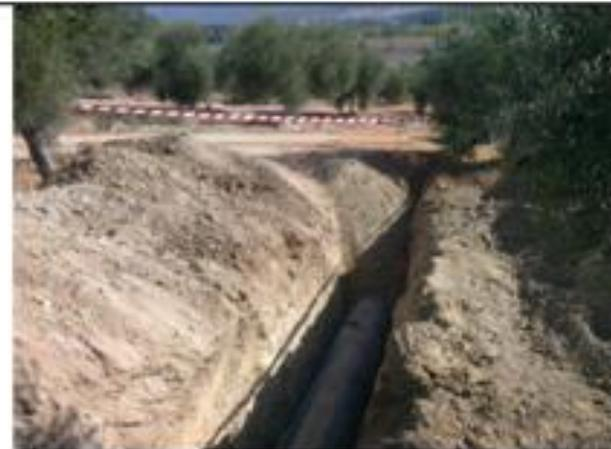
Imagen 4: Montaje de tubería de PEAD 630 mm en la impulsión con rampas para salida de animales de la zanja P.K. 0+096
