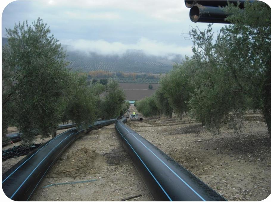
**Tubería PEAD 630 mm soldada antes de su colocación en el interior del antiguo canal**
