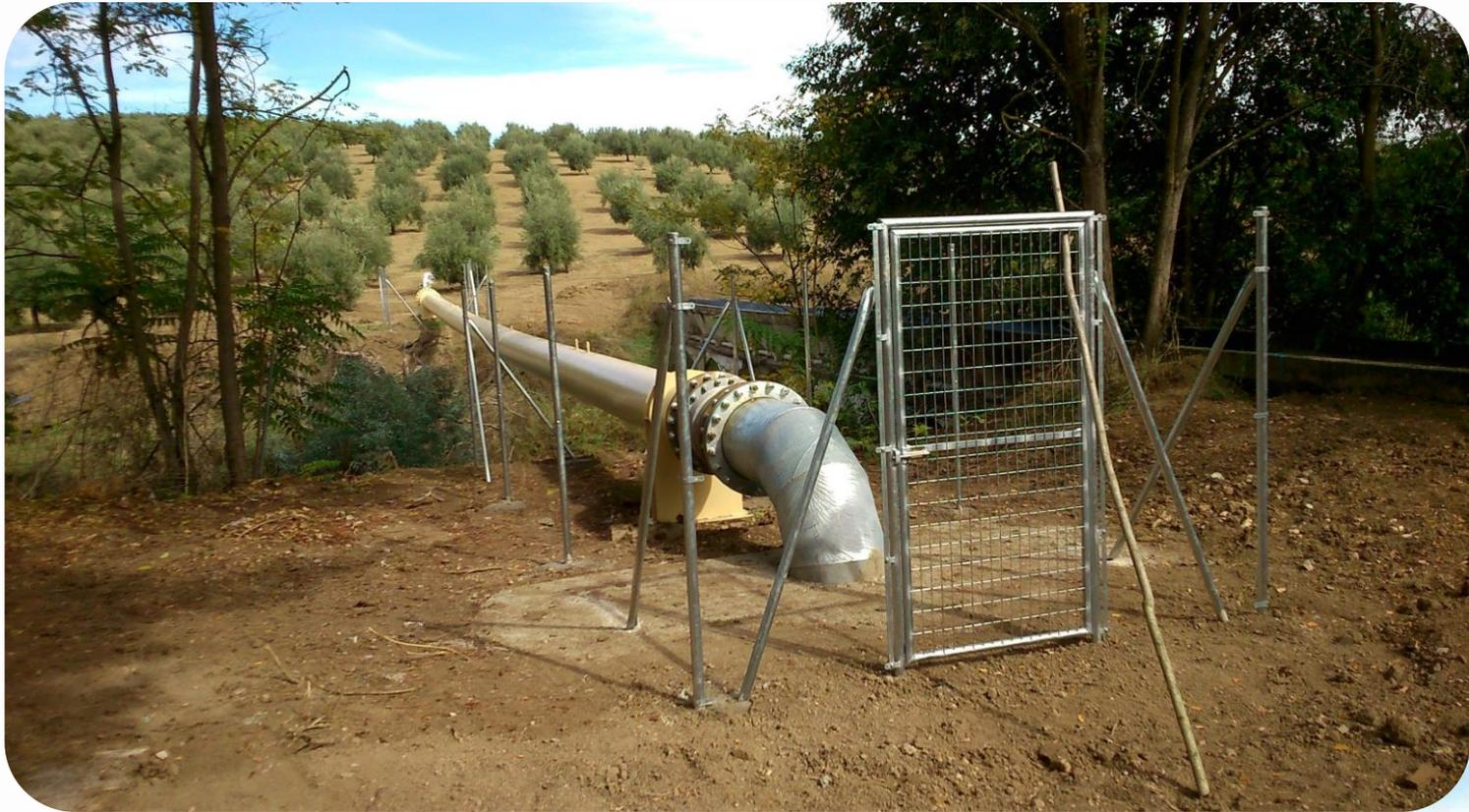
**Vista del cruce del arroyo de Estevados mediante tubería autoportante**
