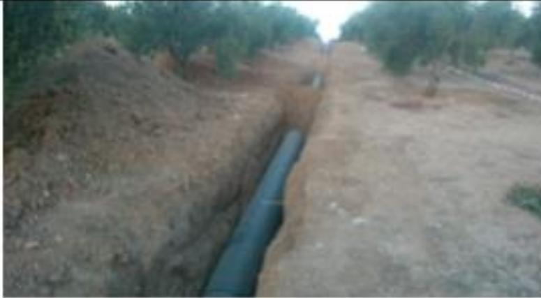
Imagen 1: Montaje de tubería de PEAD 630 mm en la impulsión con rampas para salida de animales de la zanja. P.K. 0+479
