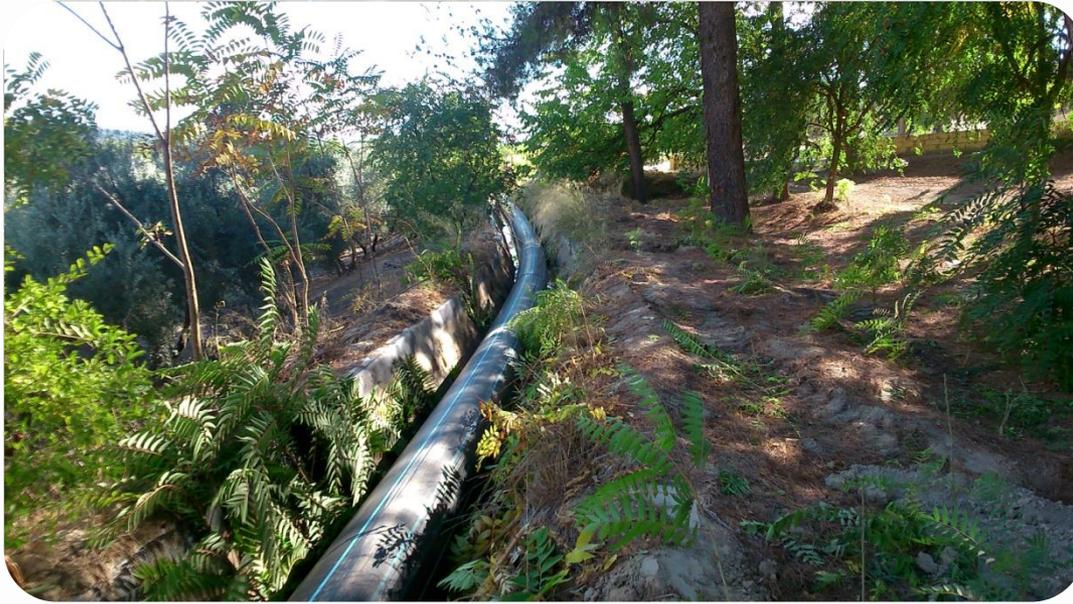
**Tubería de la Red principal colocada en el interior del canal**
