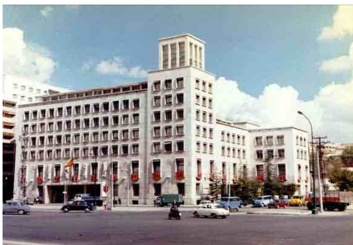
Fig. 7.- Edificio central del Instituto Nacional de Colonización, hacia 1970 (Foto: MAPAMA, Mediateca, Madrid).
